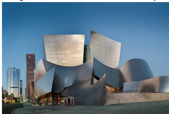
Figura 01- Parte exterior da obra Walt Disney.
