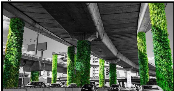
Figura 10 – Viaduto Verde na Cidade do México
