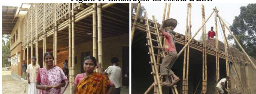
Figura 1: Construção da escola DESI.
