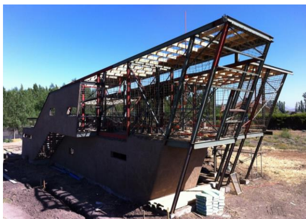
Figura 4: Estrutura e malha metálica.
