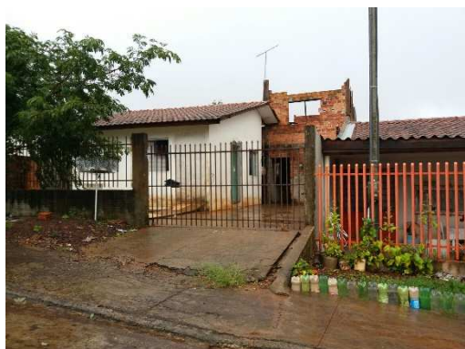
Figura 1 – Anexo em construção
