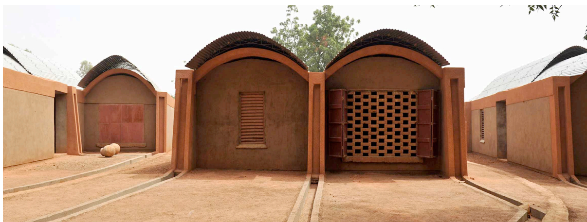
Figura 4 - Revestimento e telhado das casas dos professores de Gando
