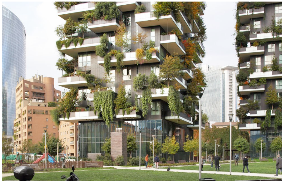
Imagem 03: Edifício Bosco Verticale, Milão. Disponível em: https://www.stefanoboeriarchitetti.net/en/portfolios/bosco-verticale/ . Acesso em 03 de Junho de 2017.
