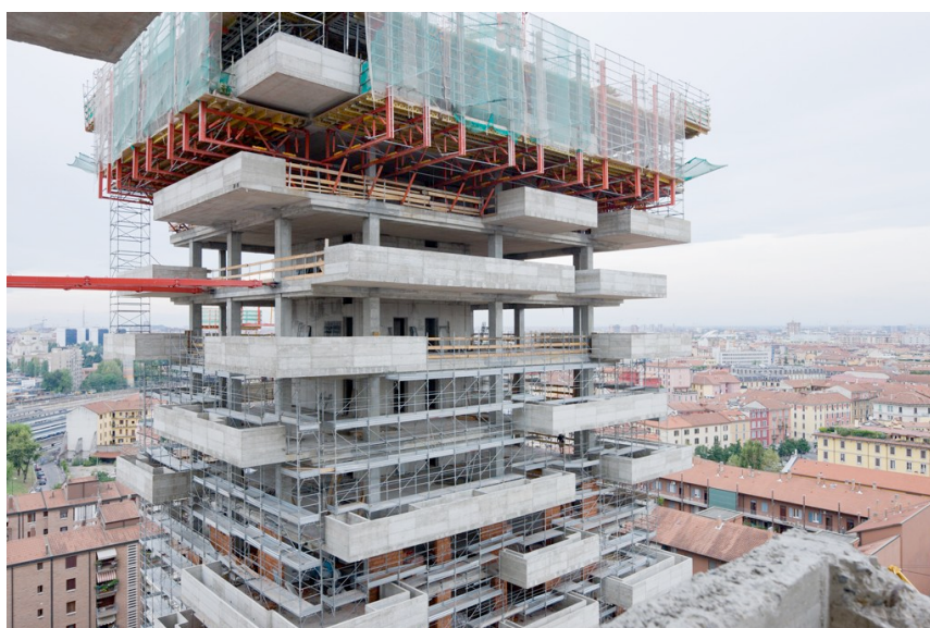
Imagem 01: Edifício Bosco Verticale em construção. Disponível em: https://www.stefano boeri architetti.net/en/portfolios/bosco-verticale/ . Acesso em 03 de Junho de 2017.
