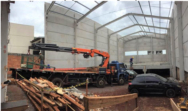
Figura 36: Uso de equipamento de segurança.
