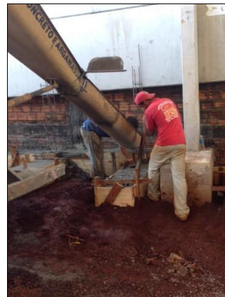
Figuras 30 e 31: Caminhão de concreto e funcionários auxiliando a concretagem.
