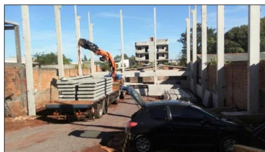
Figuras 13 e 14: Caminhão carregando as vigas e içamento da viga para instalação.
