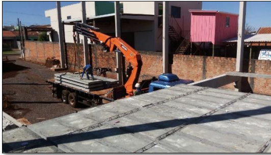
Figuras 17 e 18: Placas pré-moldadas sendo colocadas na obra com o auxílio do guincho.
