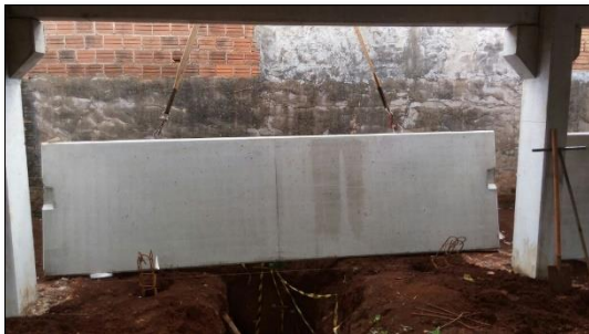
Figuras 19 e 20: Placa de fechamento e instalação das placas,
