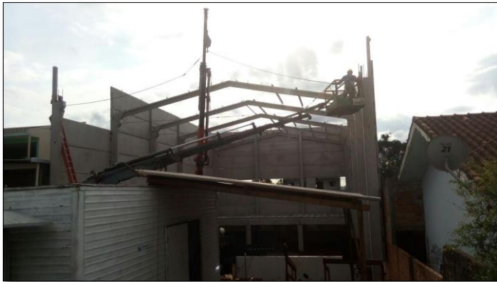
Figuras 23 e 24: Colocação da estrutura do telhado.
