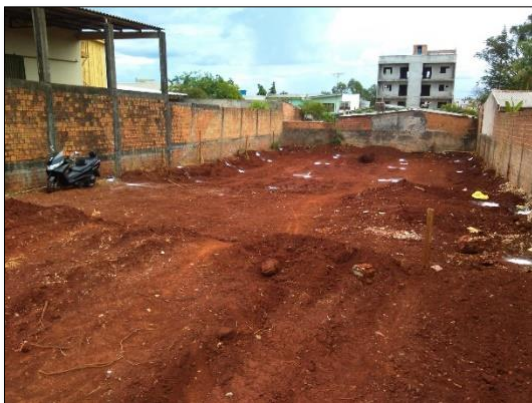
Figuras 05 e 06: Início da obra e escavação das fundações
