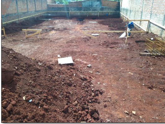
Figuras 03 e 04: Canteiro no início da obra.
