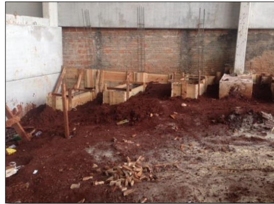
Figuras 28 e 29: Madeira para caixaria e caixarias inseridas na obra.
