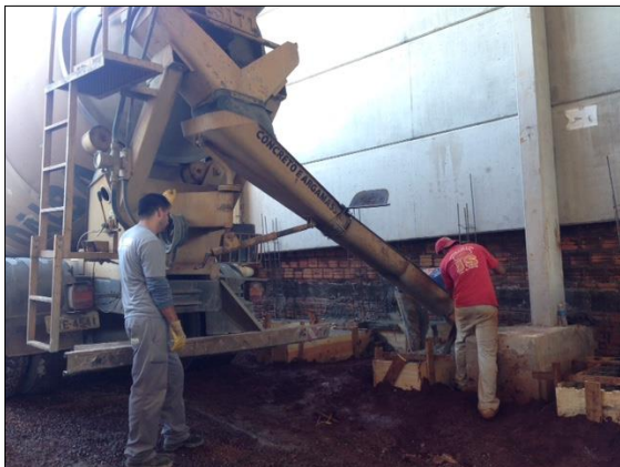
Figuras 30 e 31: Caminhão de concreto e funcionários auxiliando a concretagem.
