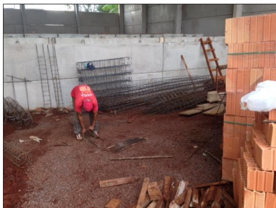
Figuras 32 e 33: Medição das ferragens e ferragens com equipamentos.
