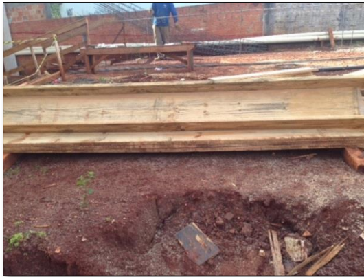
Figuras 28 e 29: Madeira para caixaria e caixarias inseridas na obra.
