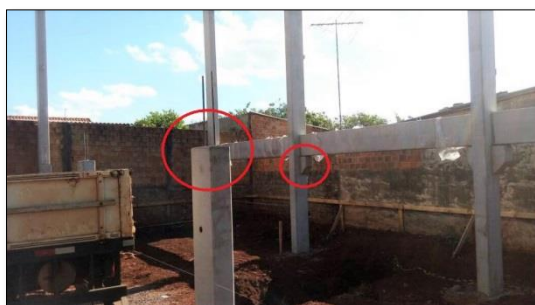
Figura 12: Encaixe das vigas sobre os pilares.
