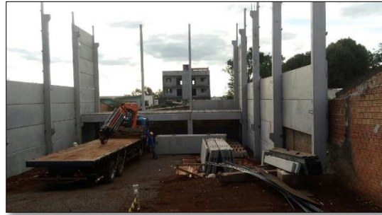
Figuras 17 e 18: Placas pré-moldadas sendo colocadas na obra com o auxílio do guincho.
