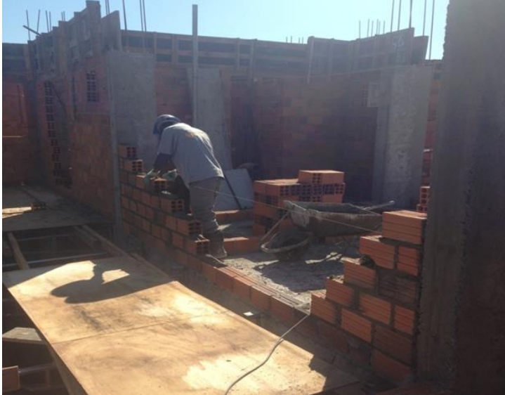
Imagem 5: Alvenaria de Vedação
