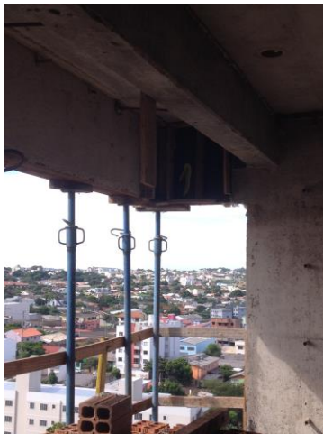
Imagem 18: Vigas e lajes
