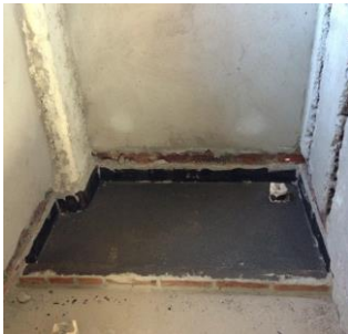
Imagem 14: Aplicação da Impermeabilização
