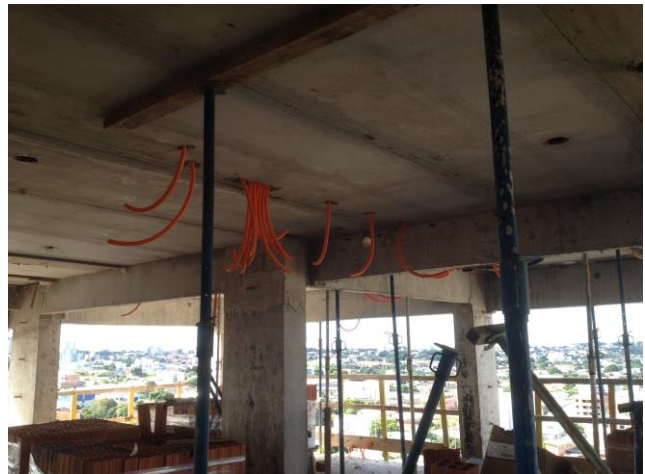
Imagem 19: Vigas e Lajes
