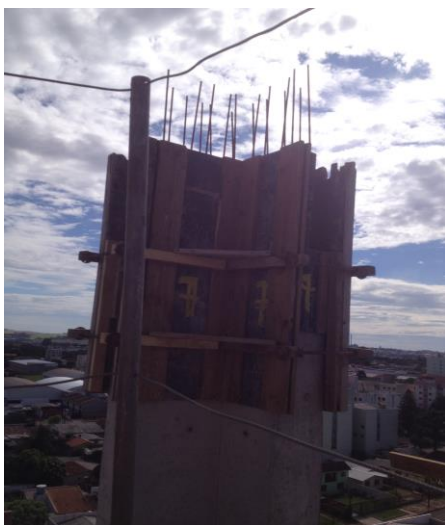
Imagem 13: Montagem da Forma
