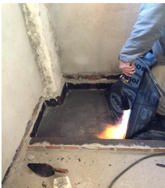
Imagem 15: Colagem da Manta Asfáltica
