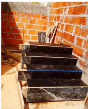
Figura 05: Colocação das Caixarias
