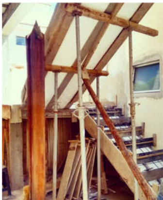
Figura 07: Colocação do Concreto
