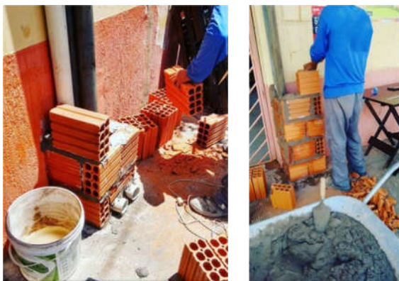
Figura 04: Assentamento de Tijolo
