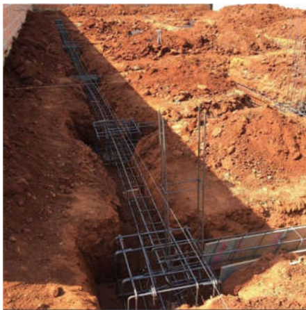
Figura 16: Colocação das ferragens
