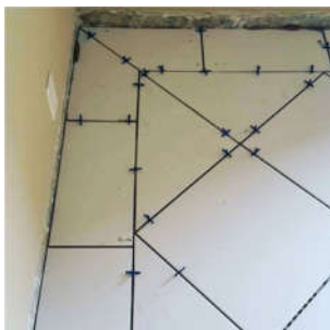
Figura 11: Preparação do Piso para Rejunte
