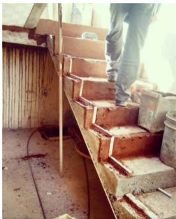
Figura 08: Cura do Concreto
