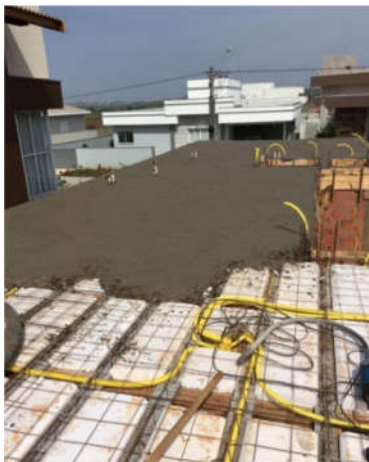
Figura 14: Colocação do concreto
