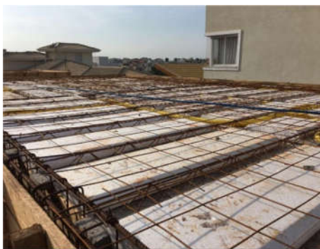
Figura 13: Colocação do Suporte, Ferragens e Isopor
