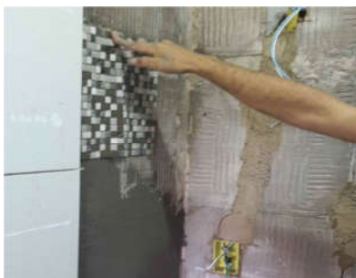
Figura 12: Colocação do Ladrilho
