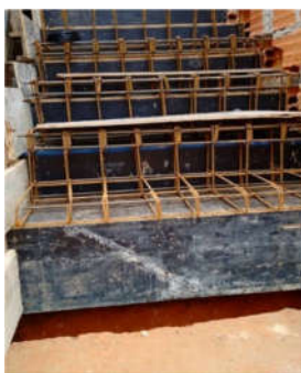
Figura 06: Colocação das Ferragens
