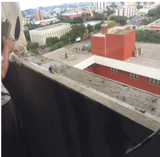
Figura 6. Preparo da base , requadro.
