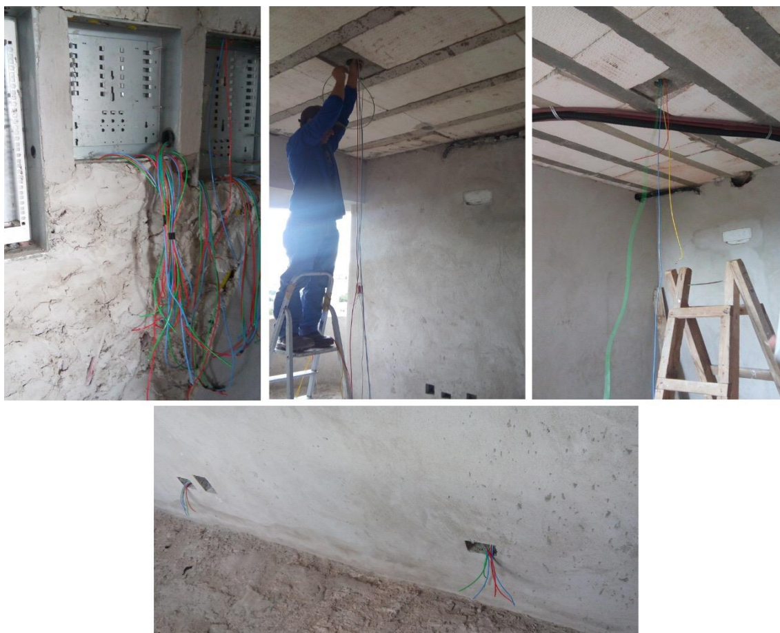
Figura 12: Quadros e passagem Instalação Elétrica.
