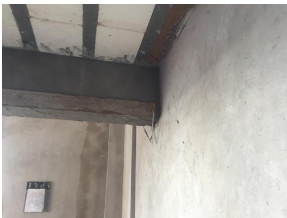
Figura 19: Requadro de vigas com argamassa
