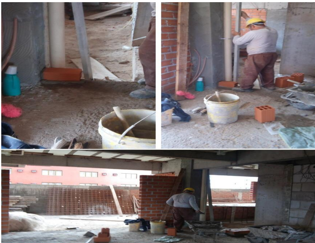
Figura 20: Fechamento em Alvenaria
