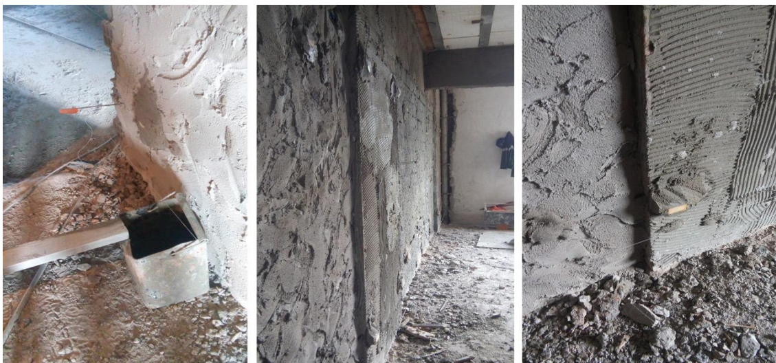
Figura 1: Parede com aplicação de Emboço.
