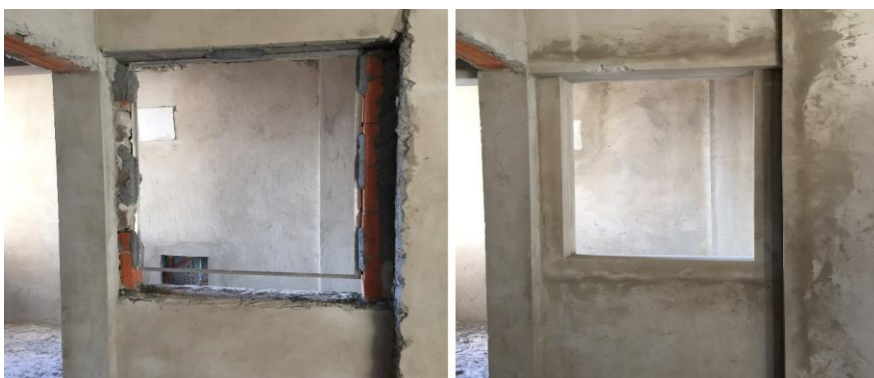
Figura 18: Requadro de esquadrias e instalação de contra-marco.
