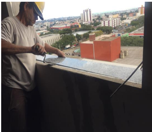
Figura 8. Assentamento da Pingadeira
