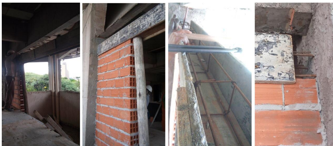
Figura 13: Montagem da caixaria para concretagem de verga
