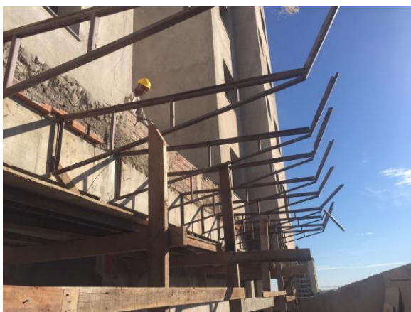
Figura 23: Estrutura metálica do Bandejão
