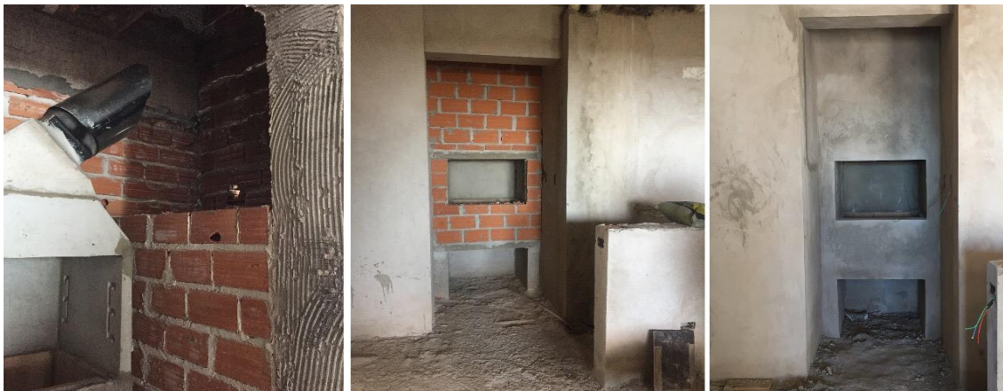
Figura 21: Instalação de churrasqueiras Pre- moldadas.
