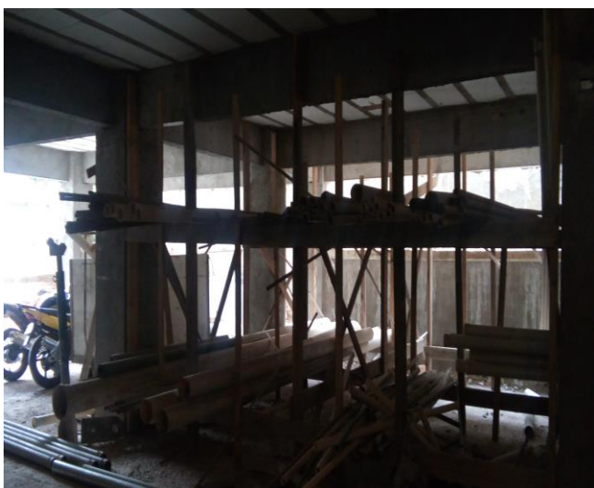
Figura: 5 Armazenamento de material hidráulico
