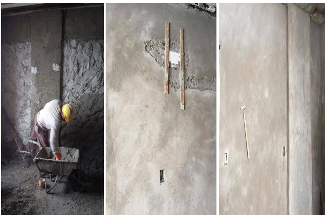
Figura 2: Aplicação do Reboco
