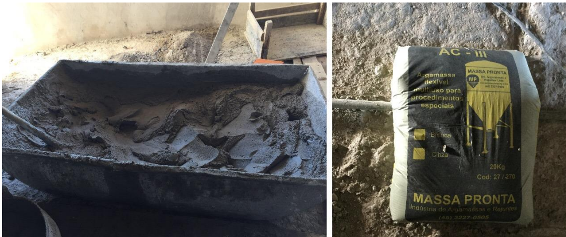
Figura17: Preparo de massa para reboco
