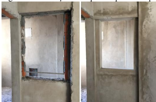
Figura 08: Instalação do requadro- para as esquadrias de alumínio
