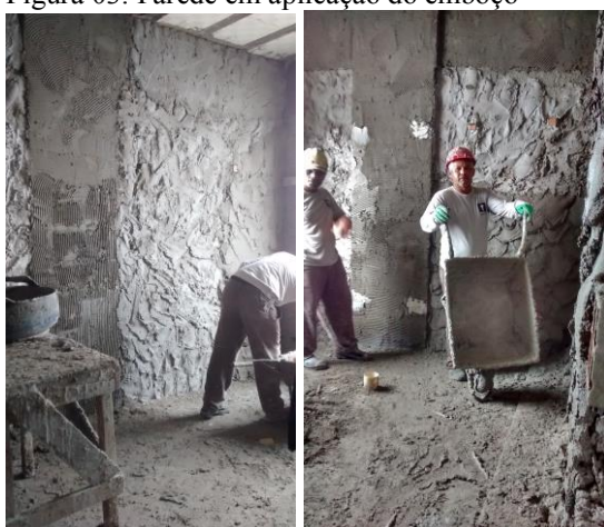
Figura 03: Parede em aplicação do emboço
