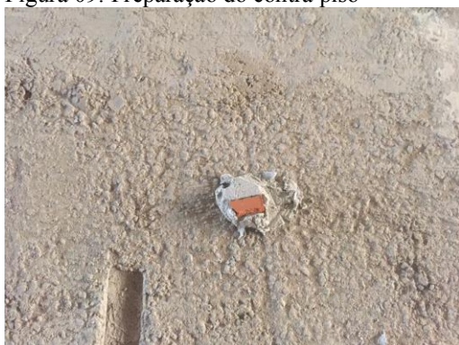
Figura 09: Preparação do contra piso
