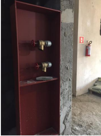
Figura 17: Instalação do hidrante
