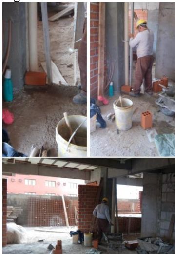
Figura 06: Fechamento em alvenaria
