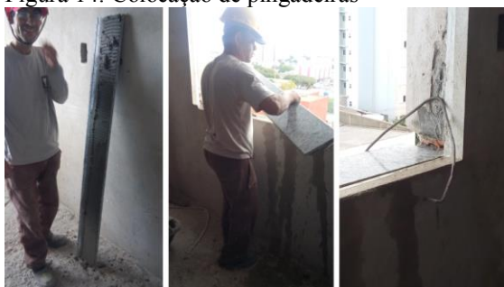
Figura 14: Colocação de pingadeiras
