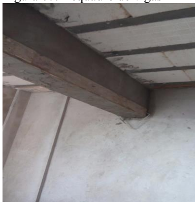
Figura 07: Requadro de vigas
