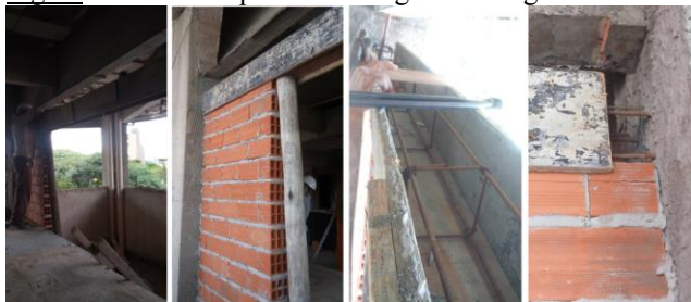
Figura 01: Caixaria para concretagem de verga
