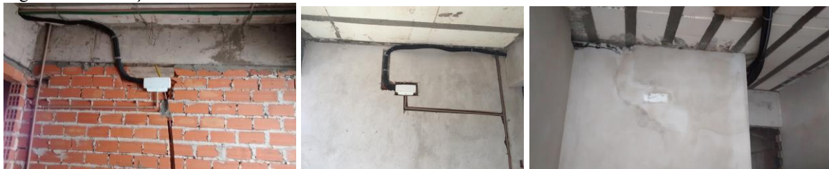
Figura 15: Instalação do ar condicionado
