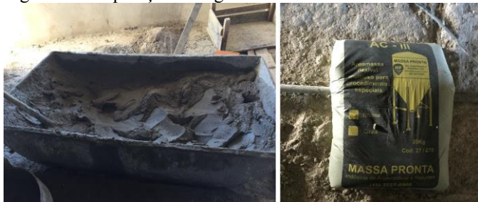
Figura 02: Preparação de argamassa
