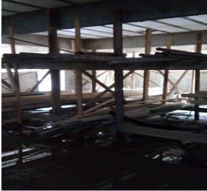
Figura 12: Armazenamento de materiais
