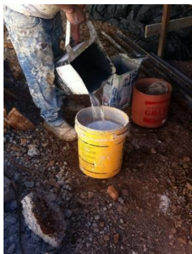
Figura 30: Mistura da argamassa com a água.
