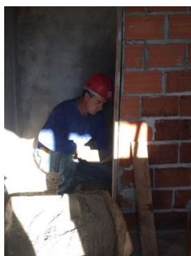
Figura 06: O pedreiro estava realizando o reboco da mureta do banheiro.
