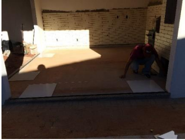
Figura 15: O profissional conferia o fio de náilon para o alinhamento das cerâmicas.
