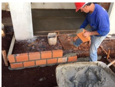
Figura 07: Aplicação do concreto e do tijolo.
