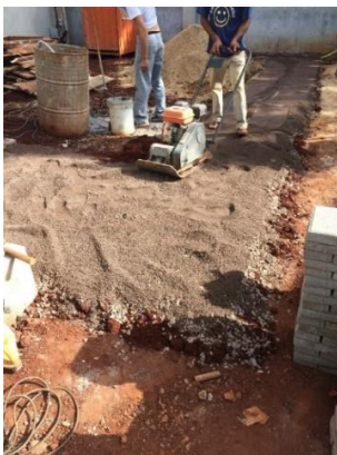
Figura 16: Máquina placa vibratória para compactar as camadas.
