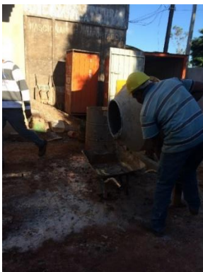
Figura 05: Betoneira estava misturando o concreto para ser despejado no carrinho.
