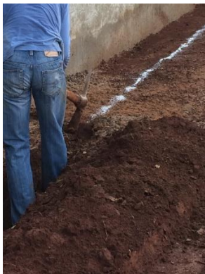
Figura 04: O pedreiro realizava a escavação para locar os canos da água pluvial.
