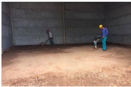
Figura 24: Compactação do piso com placa vibratória e compactador percussão.
