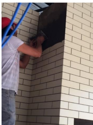
Figura 14: Aplicação da argamassa na churrasqueira.
