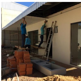
Figura 33: Aplicação do forro metálico.
