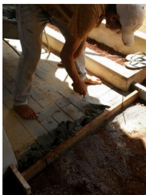
Figura 17: Aplicação do concreto ao lado dos paver.
