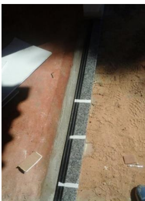
Figura 21: As fitas adesivas seguravam o perfil para não entornar na secagem do concreto.
