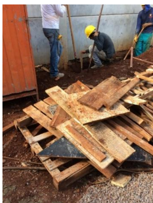
Figura 11: Medição da vala para realizarem a concretagem.
