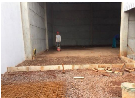
Figura 25: Compactação do piso com a placa vibratória.
