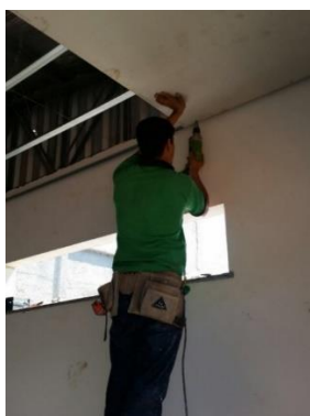
Figura 18: O profissional parafusava a placa de gesso acartonada na barra de metal.
