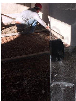
Figura 29: O pedreiro sarrafiava o concreto.
