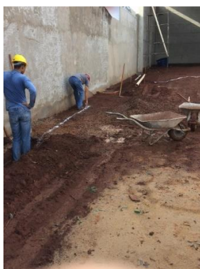
Figura 03: Aplicação de cal para escavação.
