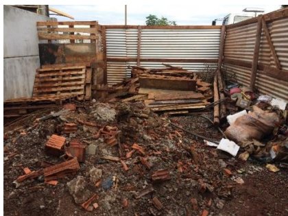
Figura 01: Entulhos da obra.
