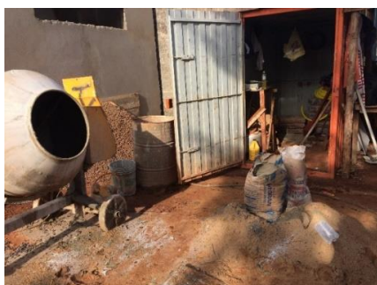
Figura 02: Contêiner para guardar as ferramentas utilizado pelos pedreiros.
