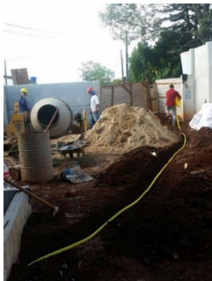
Figura 12: A vala para locar o cano de proteção do fio do interfone.
