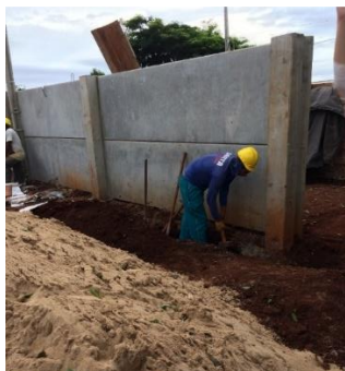
Figura 10: Escavação da vala com intuito de concretar a baldrame do portão.
