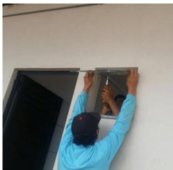
Figura 26: Parafusando o vidro no encaixe metálico
