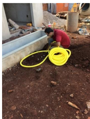
Figura 13: Encaixando o cano na caixa elétrica.
