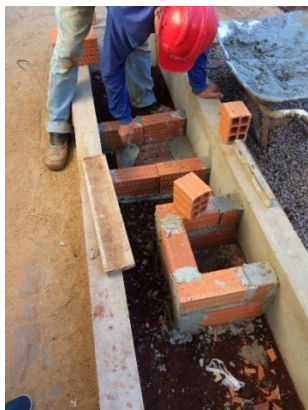
Figura 08: Aplicação do tijolo e concreto para formação da caixa de proteção.
