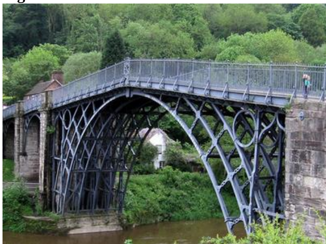
Figura 7: Ponte sobre a Severn
