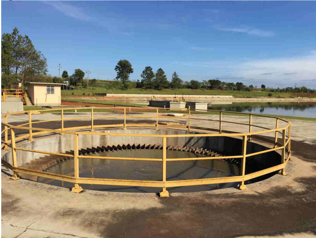
Figura 2: Vertedouro do reator UASB ETE Norte Cascavel
