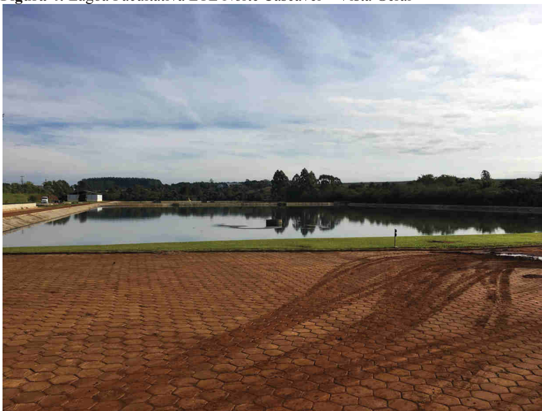
Figura 4: Lagoa Facultativa ETE Norte Cascavel – Vista Geral
