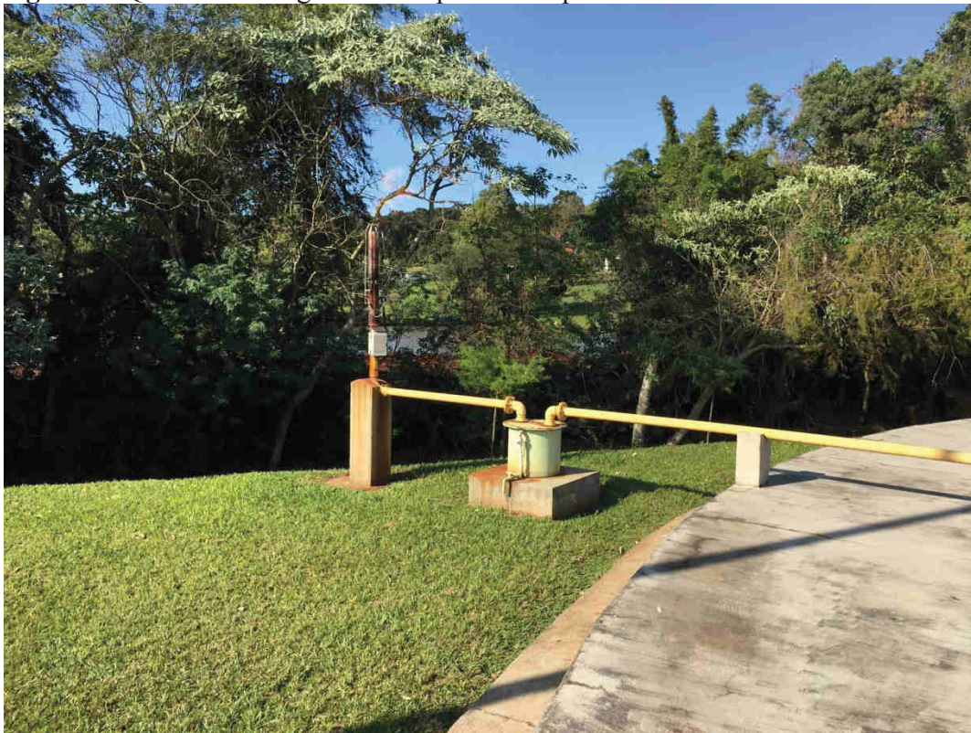
Figura 3: Queimador de gás metano produzido pelo reator UASB
