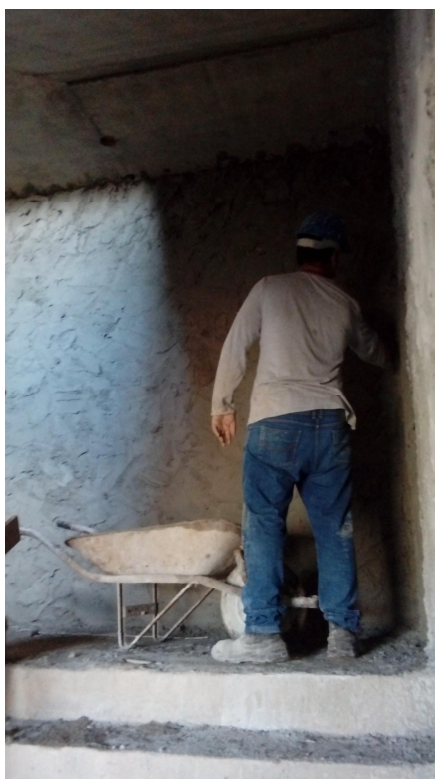
Figura 8 – Aplicação de emboço interno
