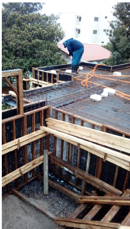
Figura 3 – Aplicação de desengripante nas fôrmas de madeira
