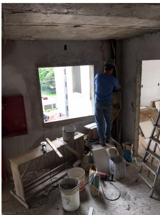
Figura 16 – Instalação de quadro de energia
