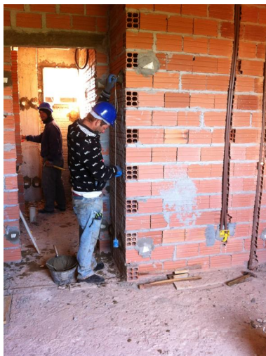
Figura 14 – Aferição de prumo da alvenaria assentada
