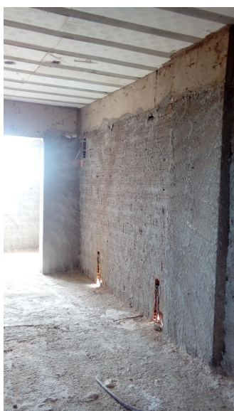
Figura 7 – Aplicação de chapisco interno
