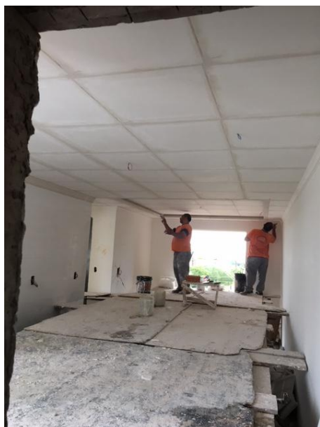
Figura 15 – Aplicação de forro de gesso
