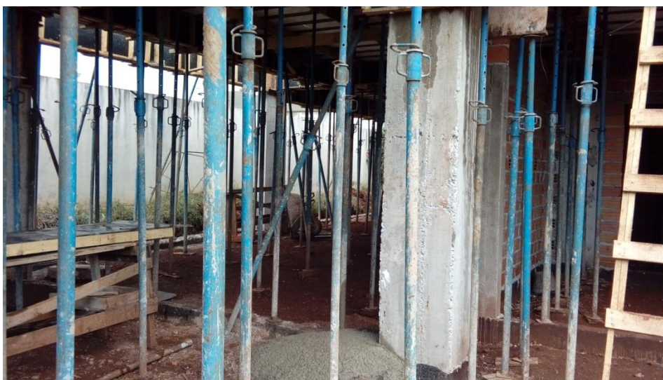
Figura 1 – Alocação de escoras metálicas no canteiro
