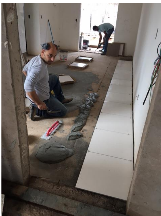
Figura 10 – Assentamento de piso
