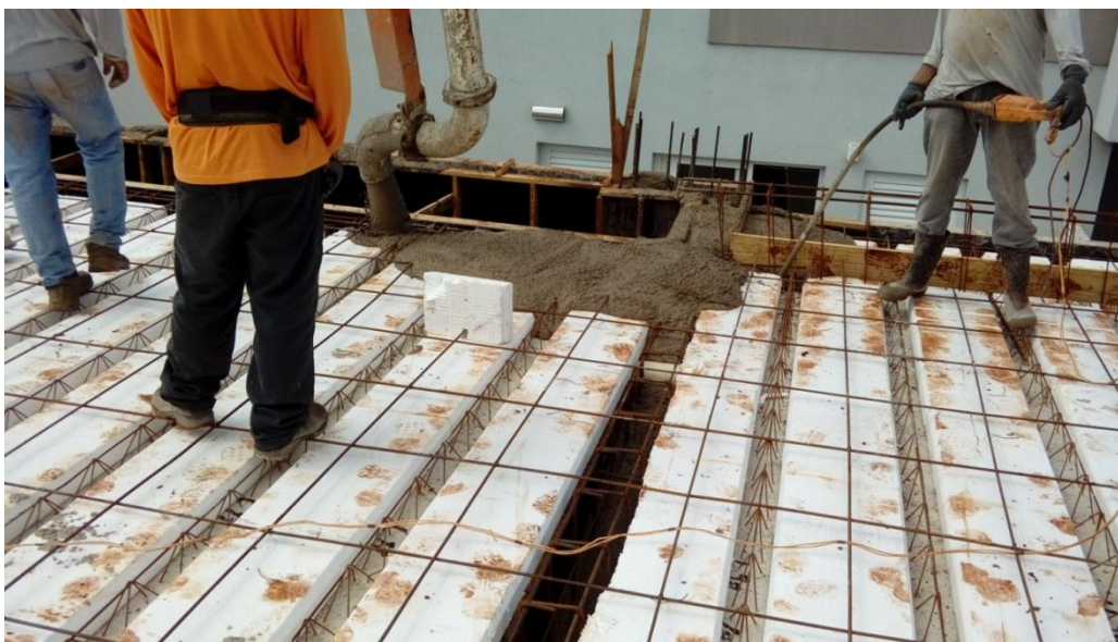
Figura 4 – Concretagem de laje com concreto usinado
