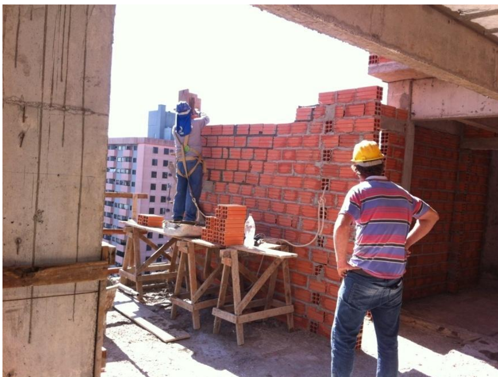
Figura 17 – Assentamento de alvenaria
