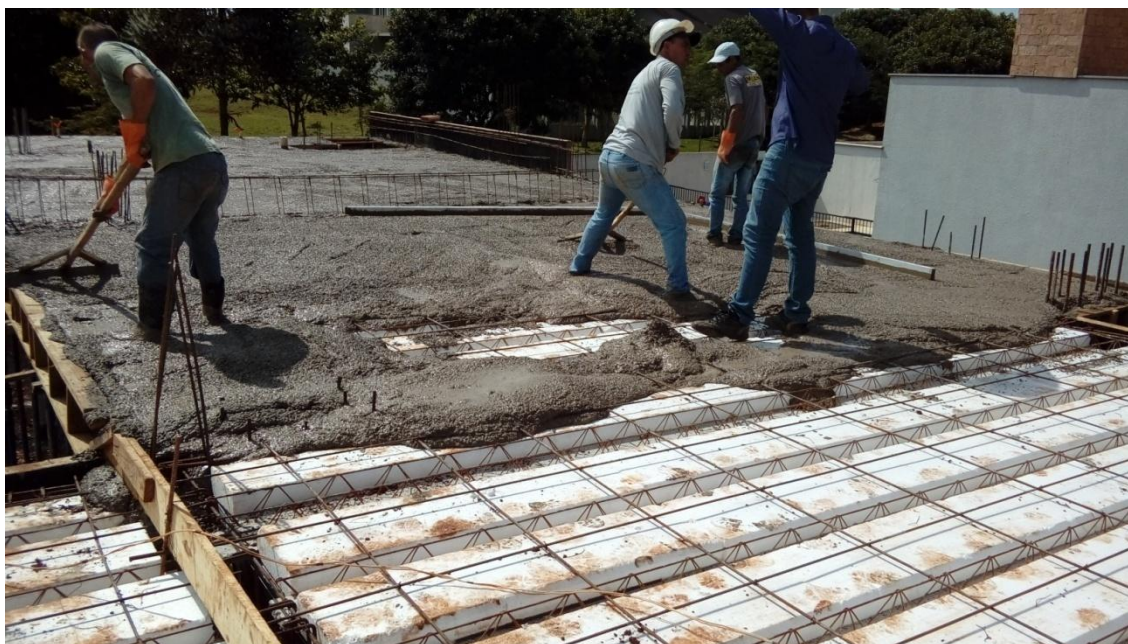
Figura 5 – Nivelamento de concreto através da utilização do rodo-float
