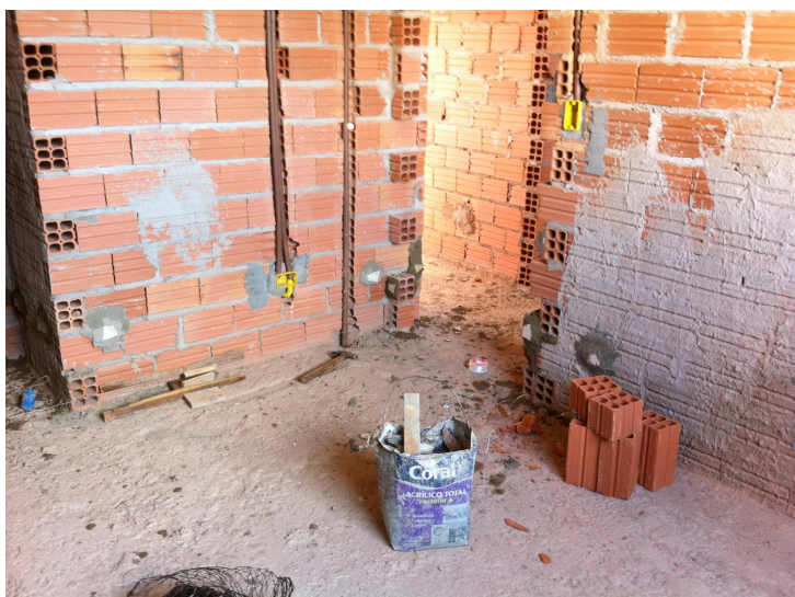
Figura 13 – Execução de recortes na alvenaria assentada para passagem de tubulação
