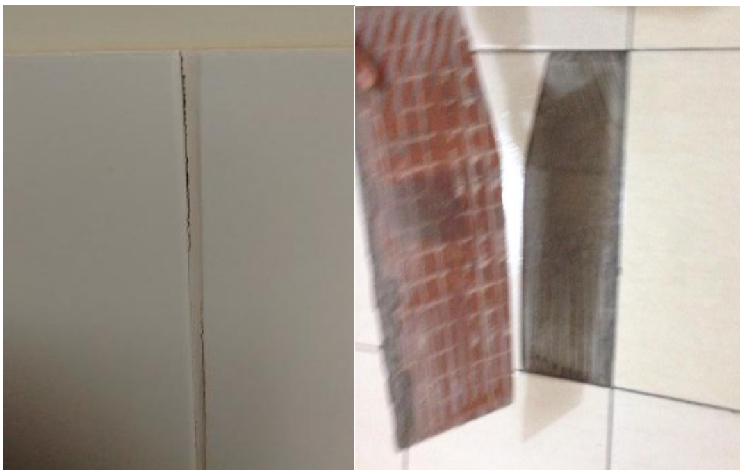
Figura 34 – Descolamento cerâmico
