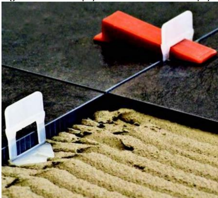
Figura 15: Uso de espaçadores no assentamento de peças cerâmicas.
