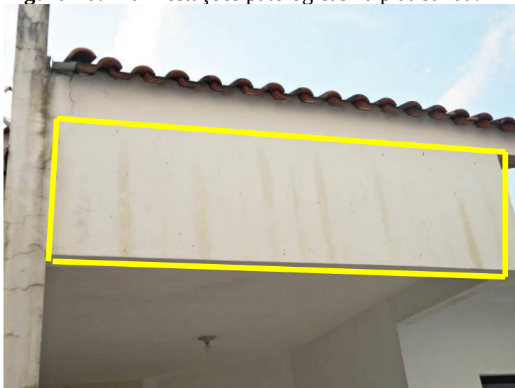
Figura 20: Manifestações patológicas na platibanda.
