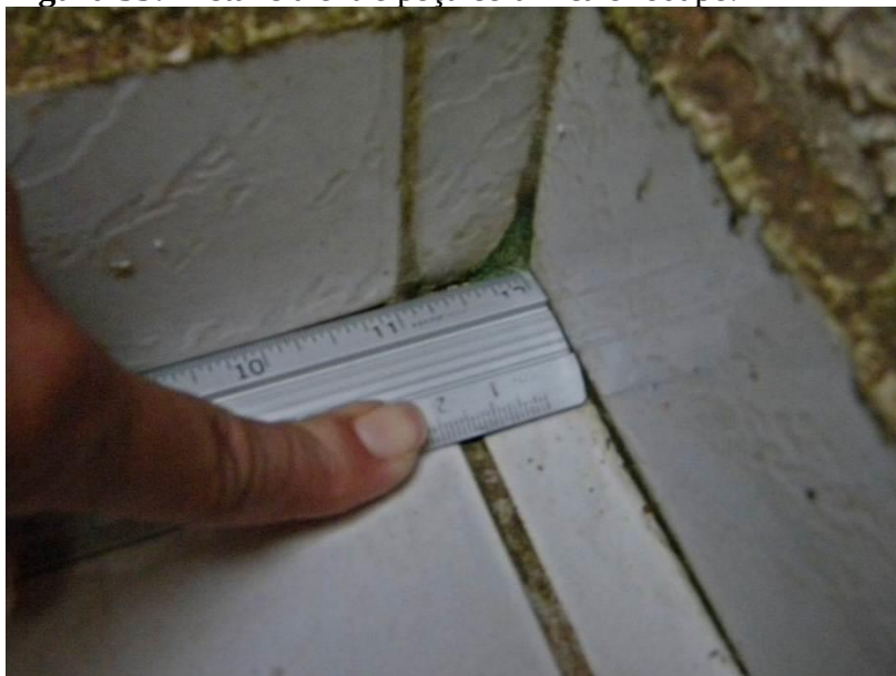
Figura 35: Distância entre peça cerâmica e rodapé.
