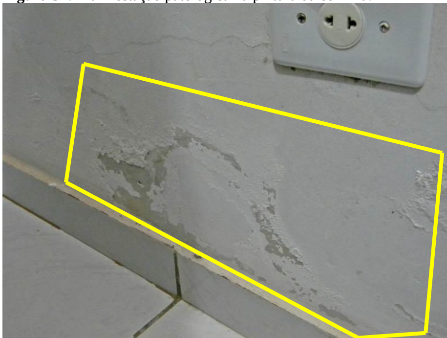
Figura 32: Manifestação patológica na pintura da cozinha.
