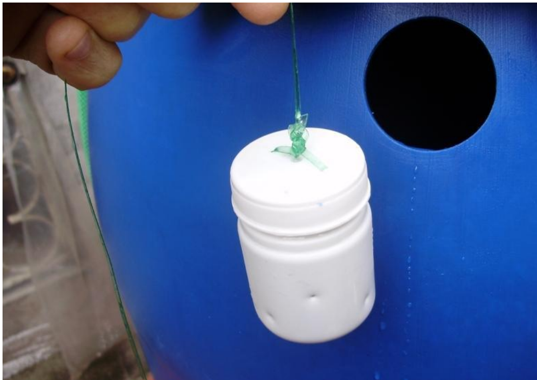
Figura 11: Detalhe do tratamento por tabletes de cloro.
