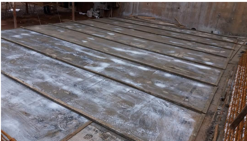
Figura 06: Fôrma para produção das PLT's
