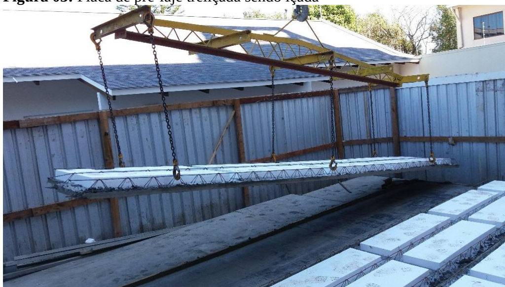
Figura 03: Placa de pré-laje treliçada sendo içada
