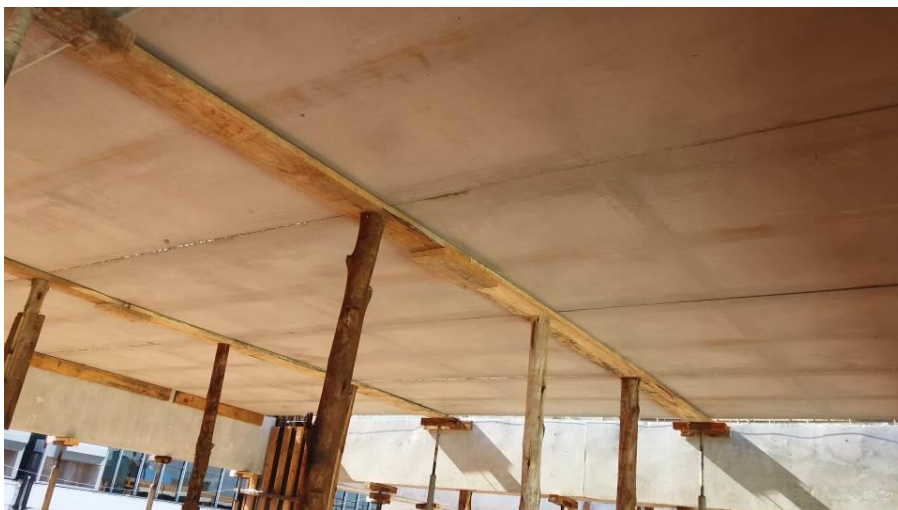
Figura 13: Parte inferior de um laje montada com PLP's
