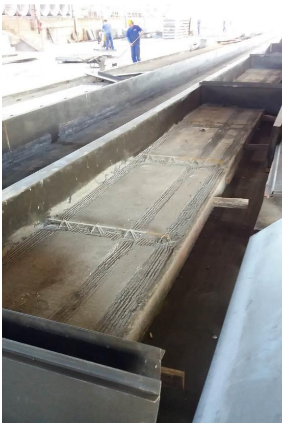
Figura 11: Fôrma das PLPs
