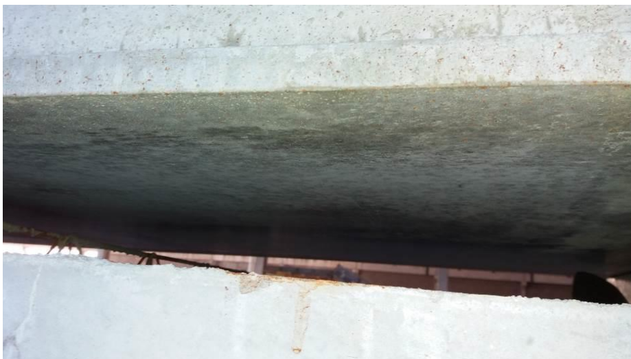
Figura 12: Acabamento da placa pré-fabricada
