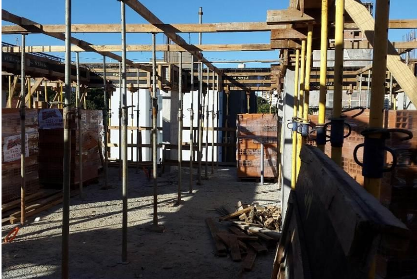
Figura 05: Sistema de escoramento
