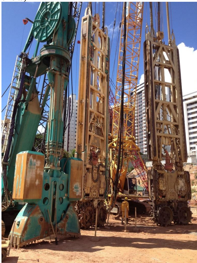
Figura 17: Equipamento para execução de estaca barrete “clamshell” (esquerda) e hidrofresa (centro e direita)
