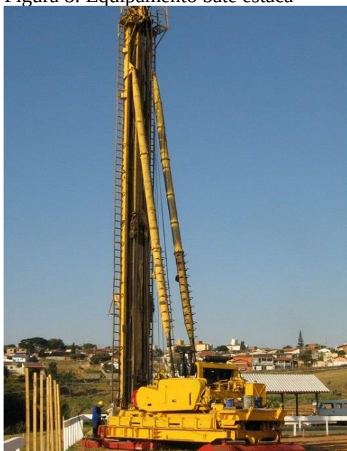
Figura 8: Equipamento bate estaca
