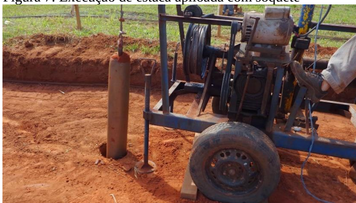
Figura 7: Execução de estaca apiloada com soquete
