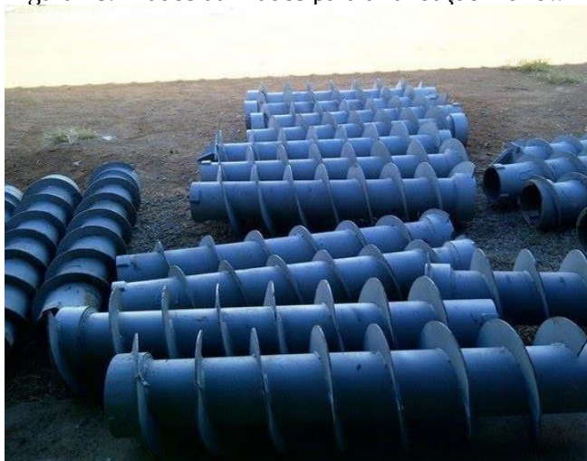
Figura 18: Trados utilizados para a fundação Hollow Auger
