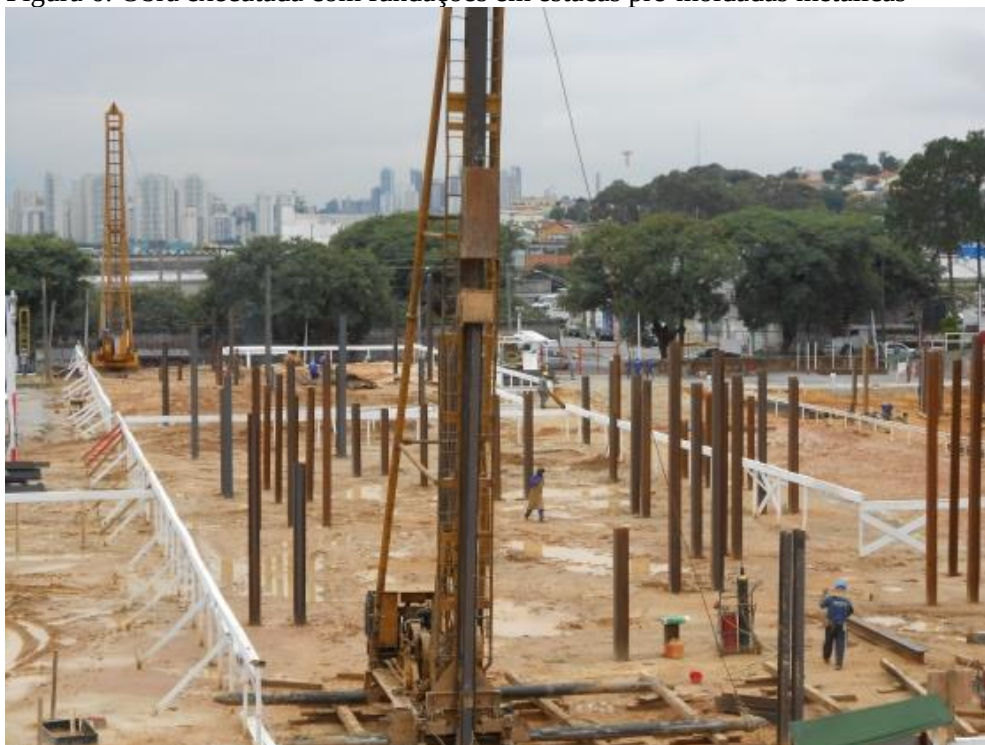
Figura 6: Obra executada com fundações em estacas pré-moldadas metálicas
