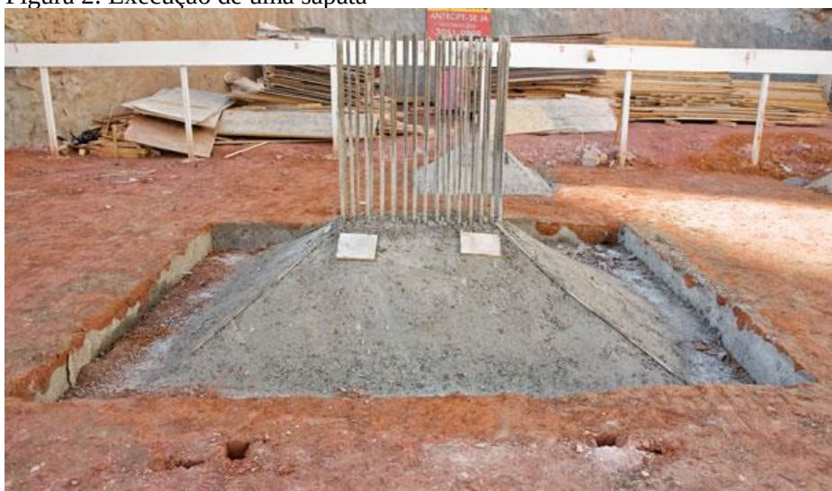
Figura 2: Execução de uma sapata
