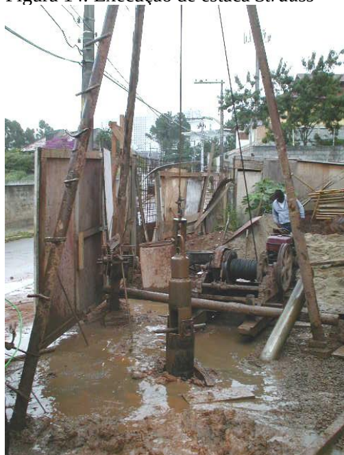
Figura 14: Execução de estaca Strauss
