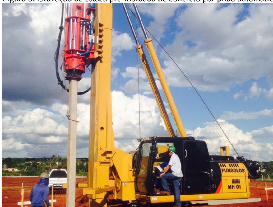
Figura 5: Cravação de estaca pré-moldada de concreto por pilão automático (martelo diesel)
