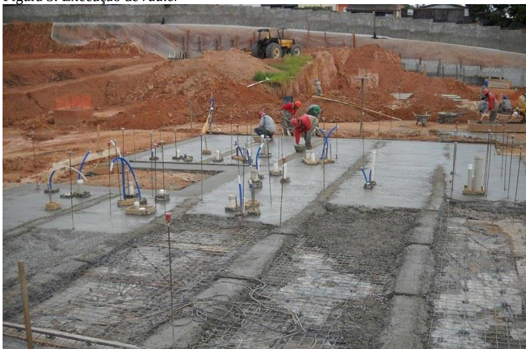
Figura 3: Execução de radier
