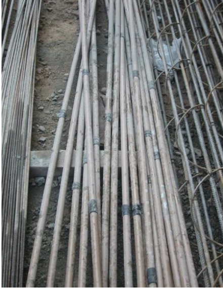
Figura 20: Tubos de injeção com manchetes
