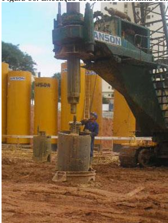
Figura 16: Execução de estacão com lama bentonítica
