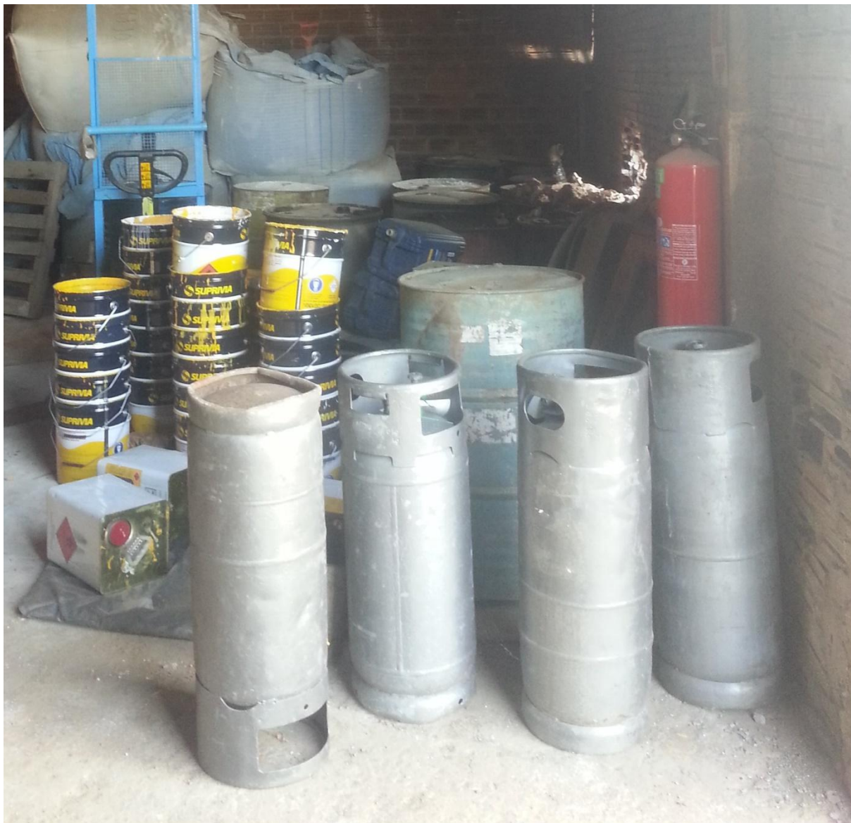
Figura 2: Extintor obstruído no depósito
