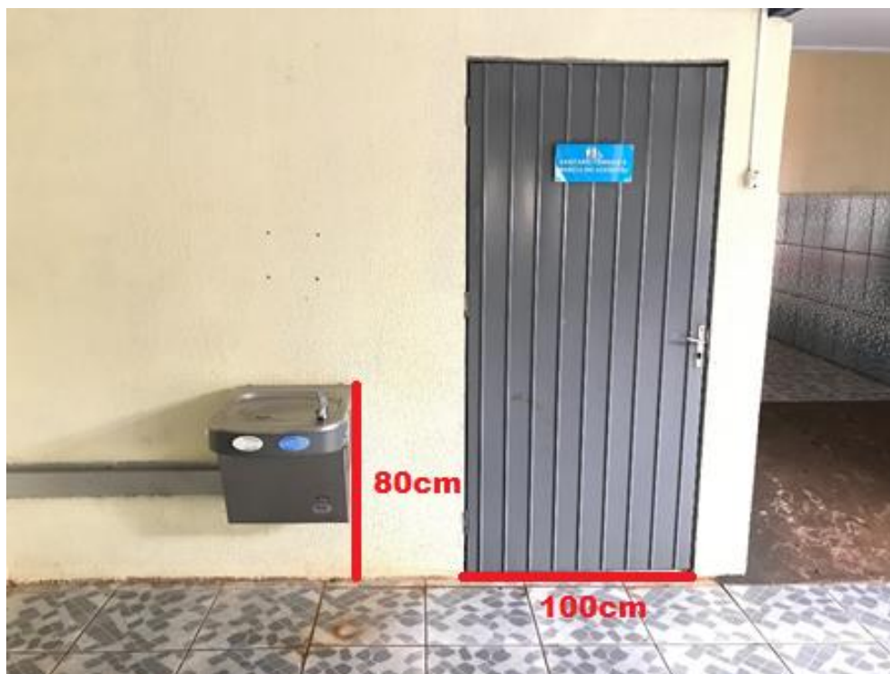
Figura 32 - Aberturas do banheiro acessível.
