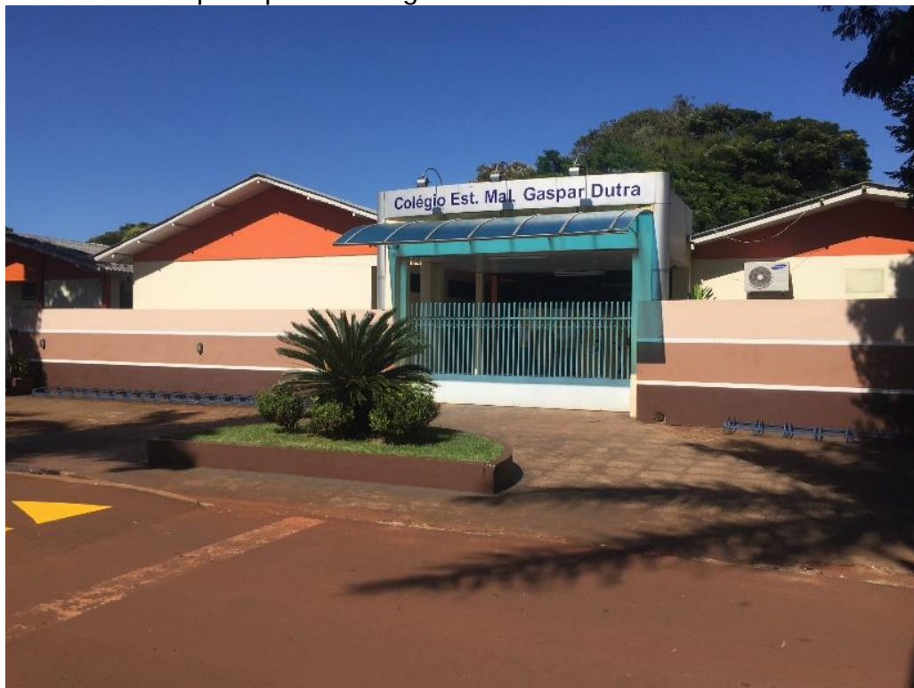
Figura 15 - Fachada principal do colégio.
