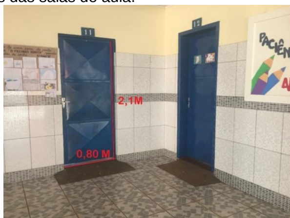
Figura 35 - Aberturas das salas de aula.
