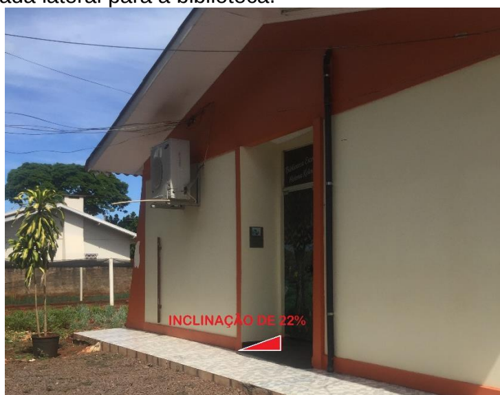
Figura 20 - Entrada lateral para a biblioteca.
