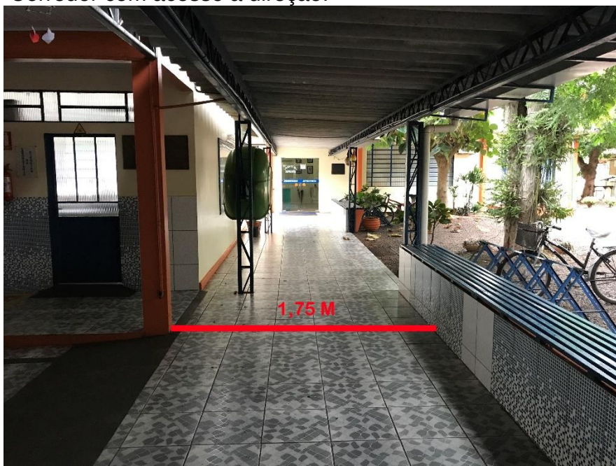
Figura 25 - Corredor com acesso à direção.
