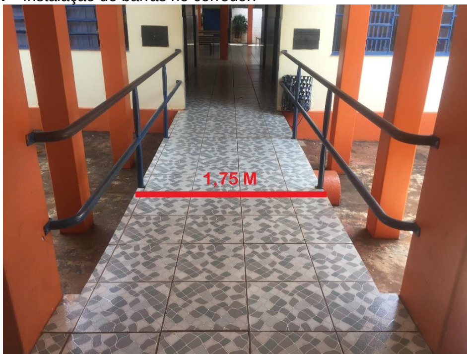
Figura 27 - Instalação de barras no corredor.
