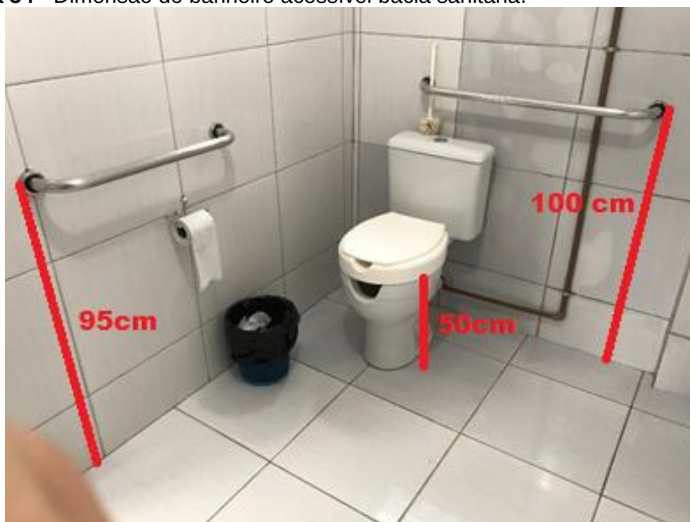
Figura 34 - Dimensão do banheiro acessível bacia sanitária.
