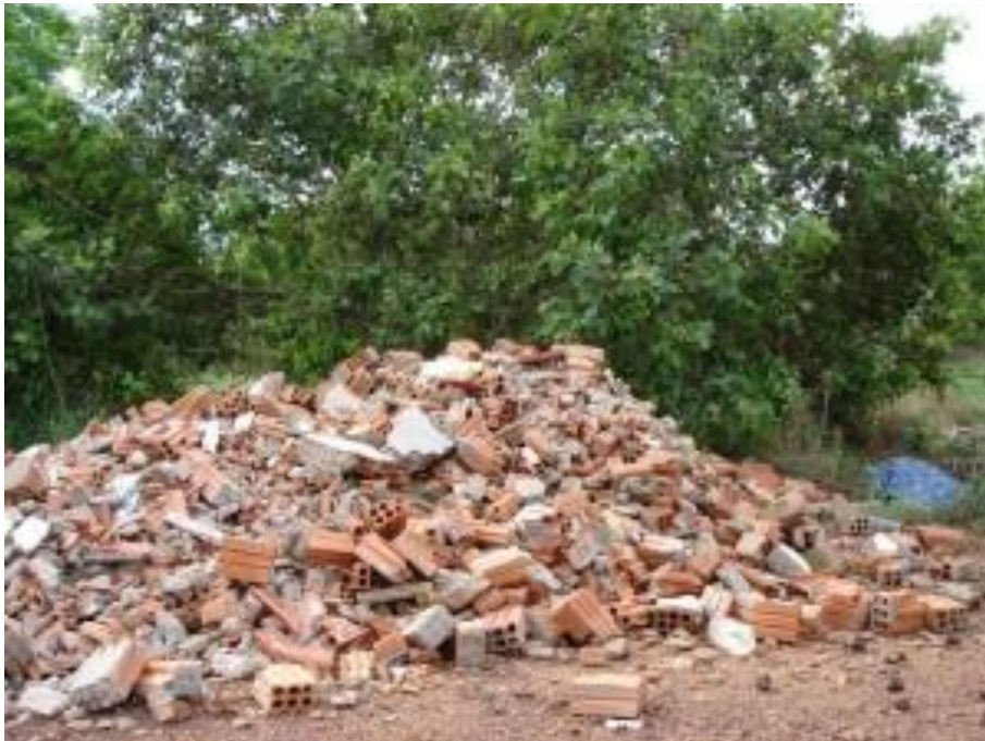
Figura 2: Resíduos de construção civil.
