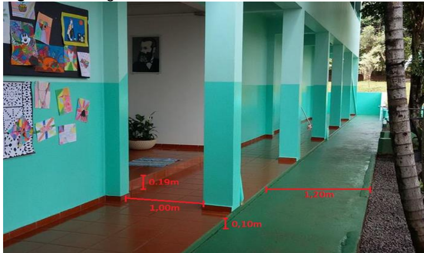
Figura 46: Degrau de acesso as salas administrativas
