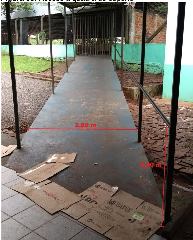
Figura 55: Acesso à quadra de esporte
