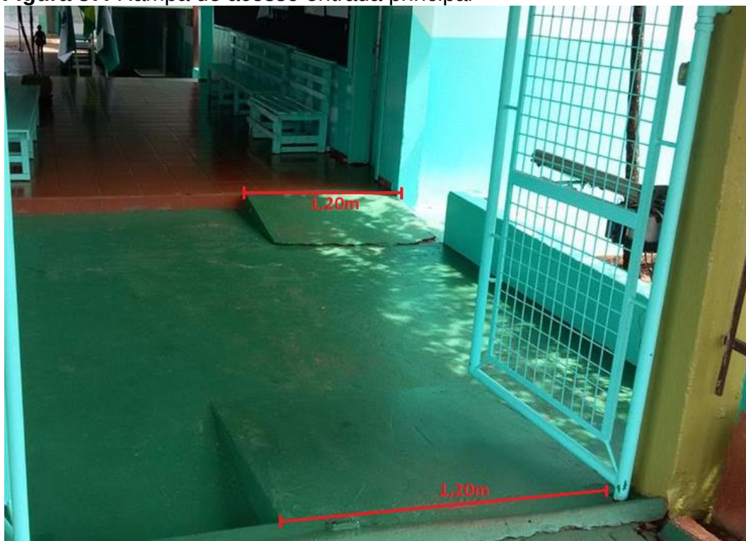
Figura 37: Rampa de acesso entrada principal
