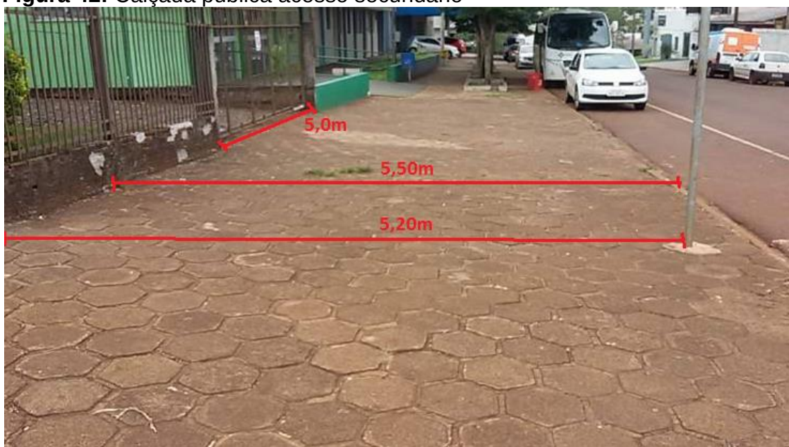
Figura 42: Calçada publica acesso secundário
