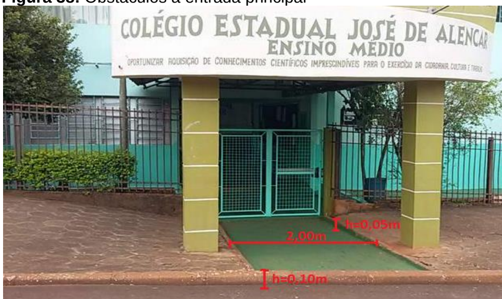
Figura 38: Obstáculos à entrada principal
