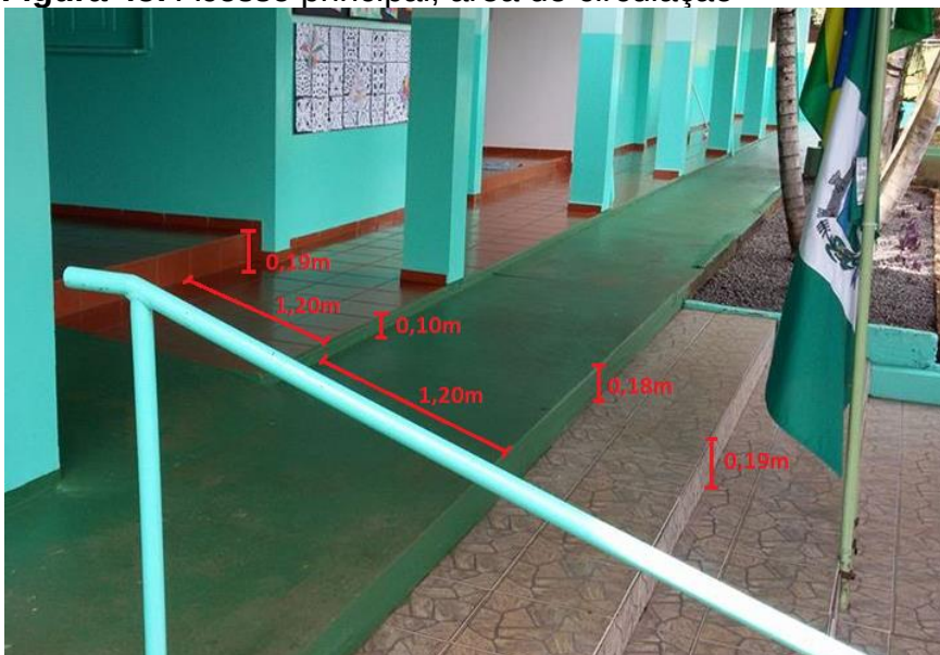
Figura 45: Acesso principal, área de circulação
