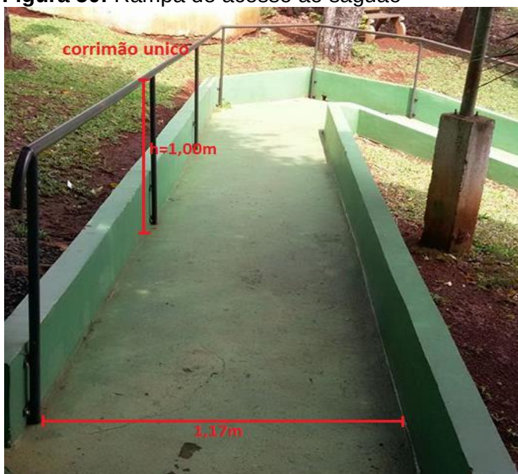
Figura 50: Rampa de acesso ao saguão
