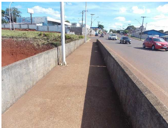
(b) Guarda-corpos em bom estado de conservação.
