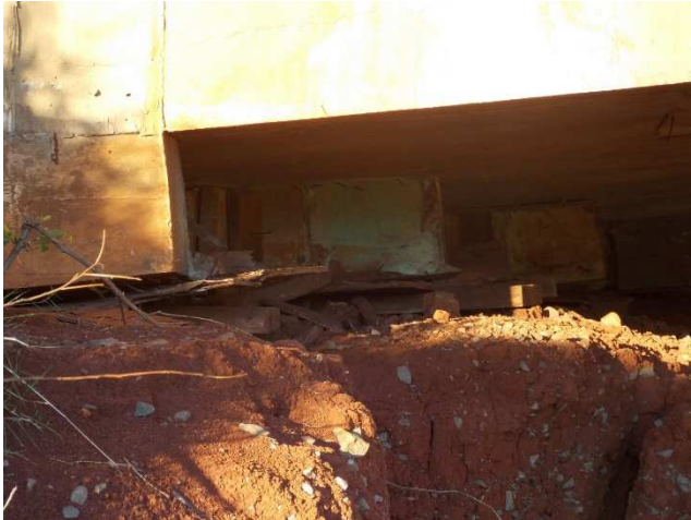
Figura 21: Apoio inadequado
