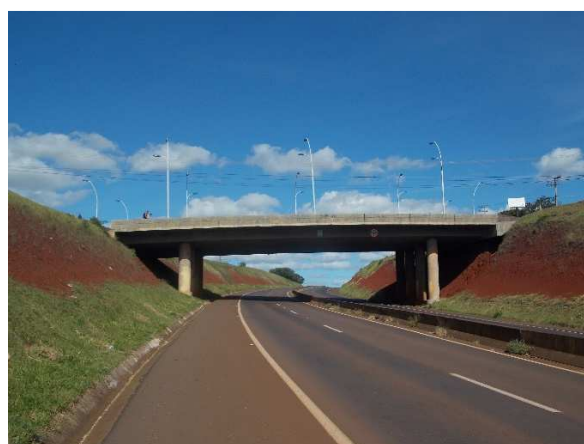
(b) Viaduto Avenida Rocha Pombo.
