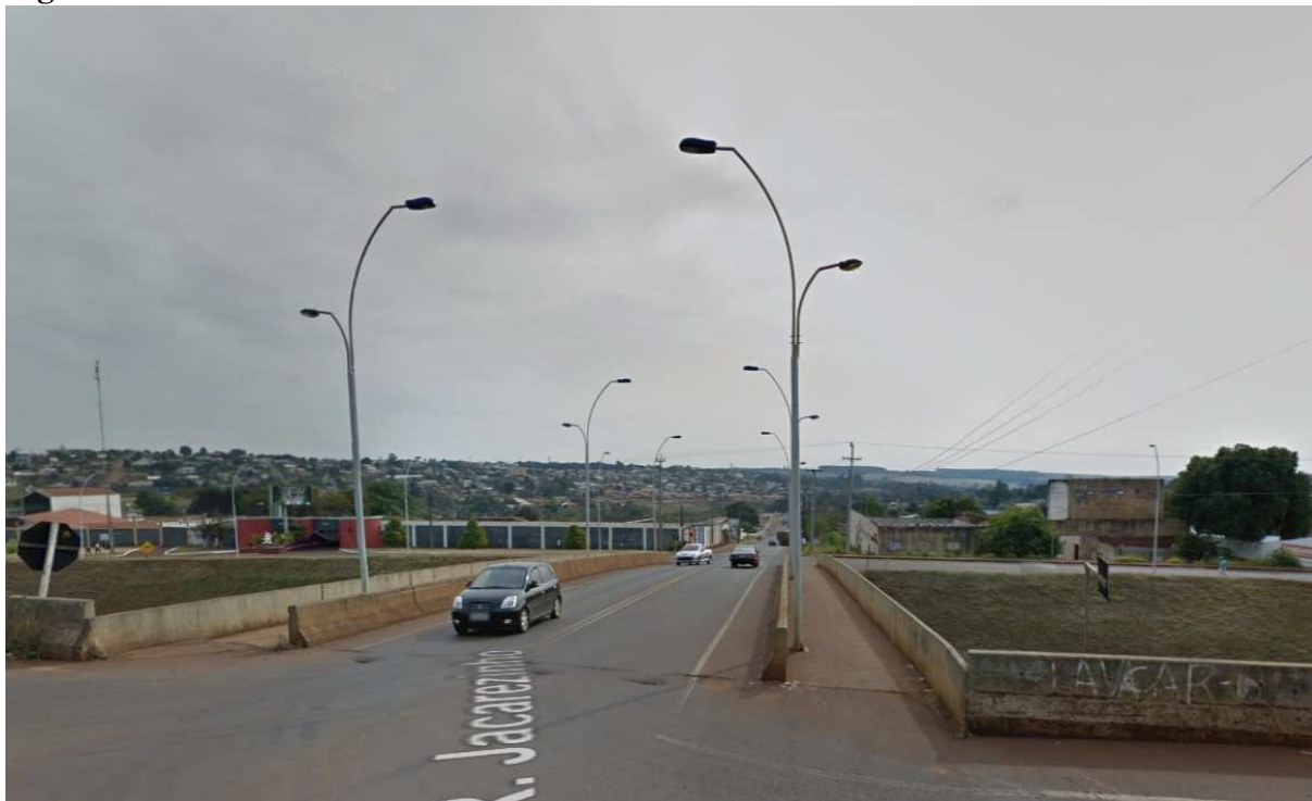
Figura 12: Viaduto Rua Jacarezinho
