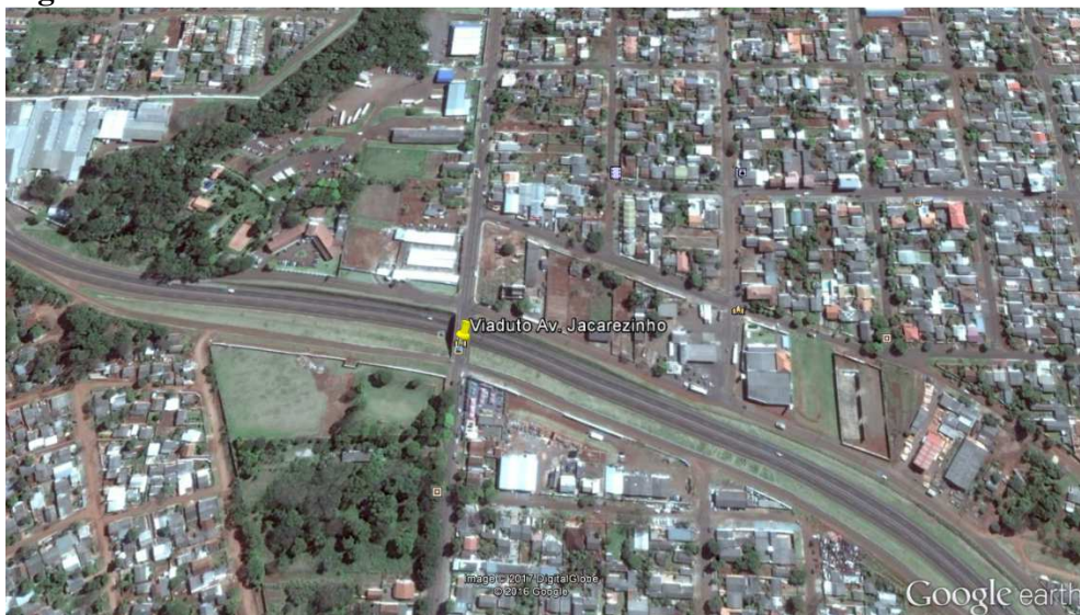
Figura 10: Estrutura localizada na Rua Jacarezinho
