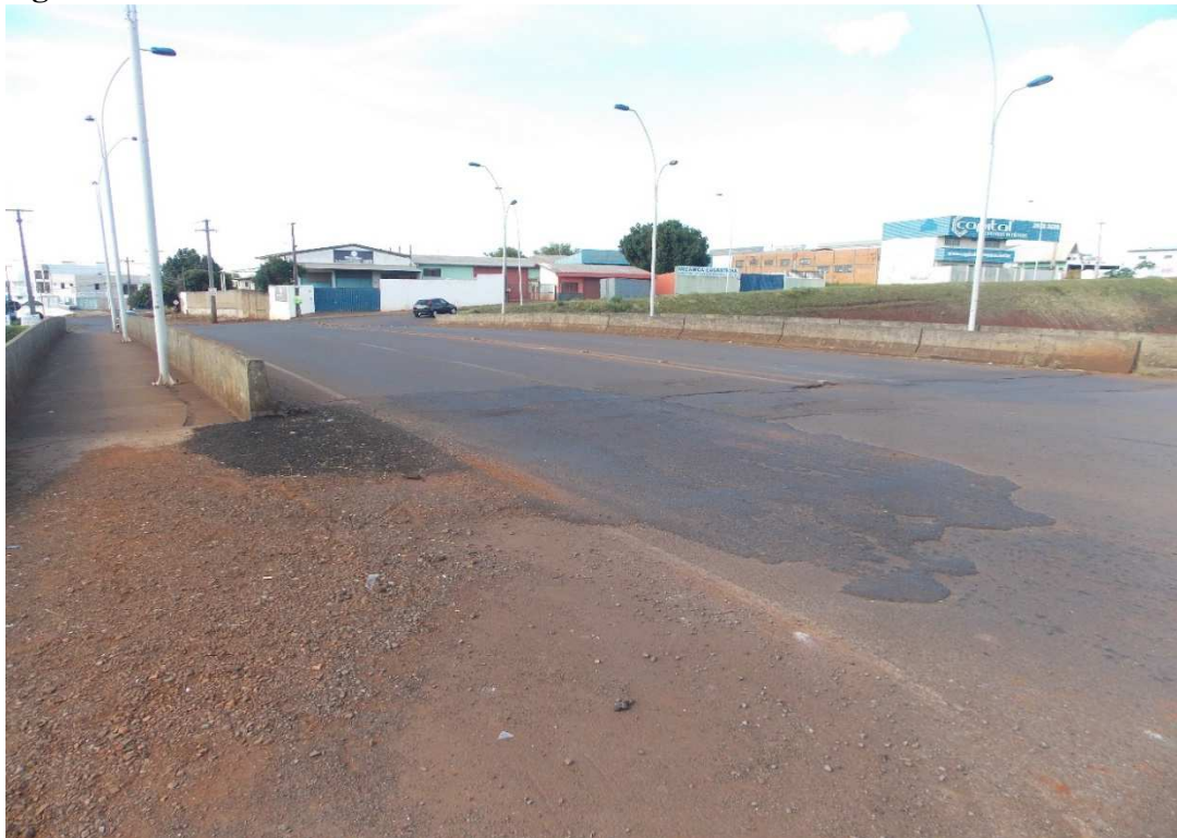
Figura 11: Viaduto Av. Rocha Pombo
