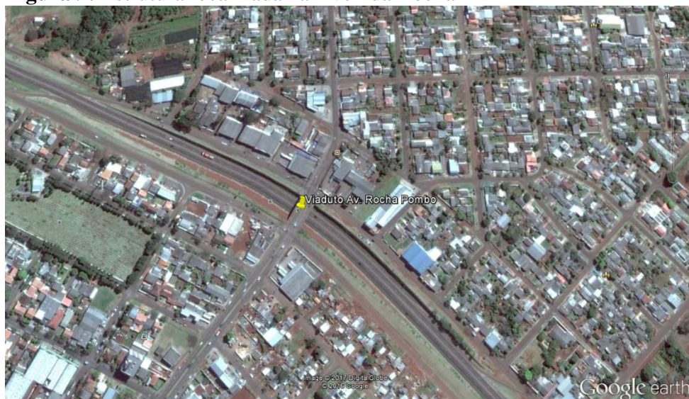
Figura 9: Estrutura localizada na Avenida Rocha
