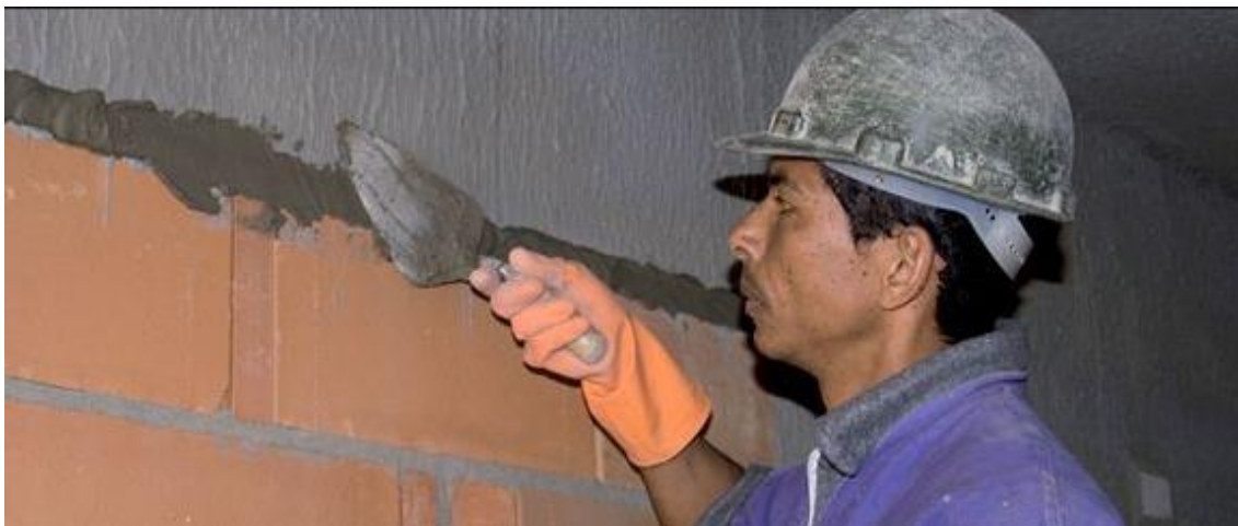
Figura 17: Encunhamento sendo executado
