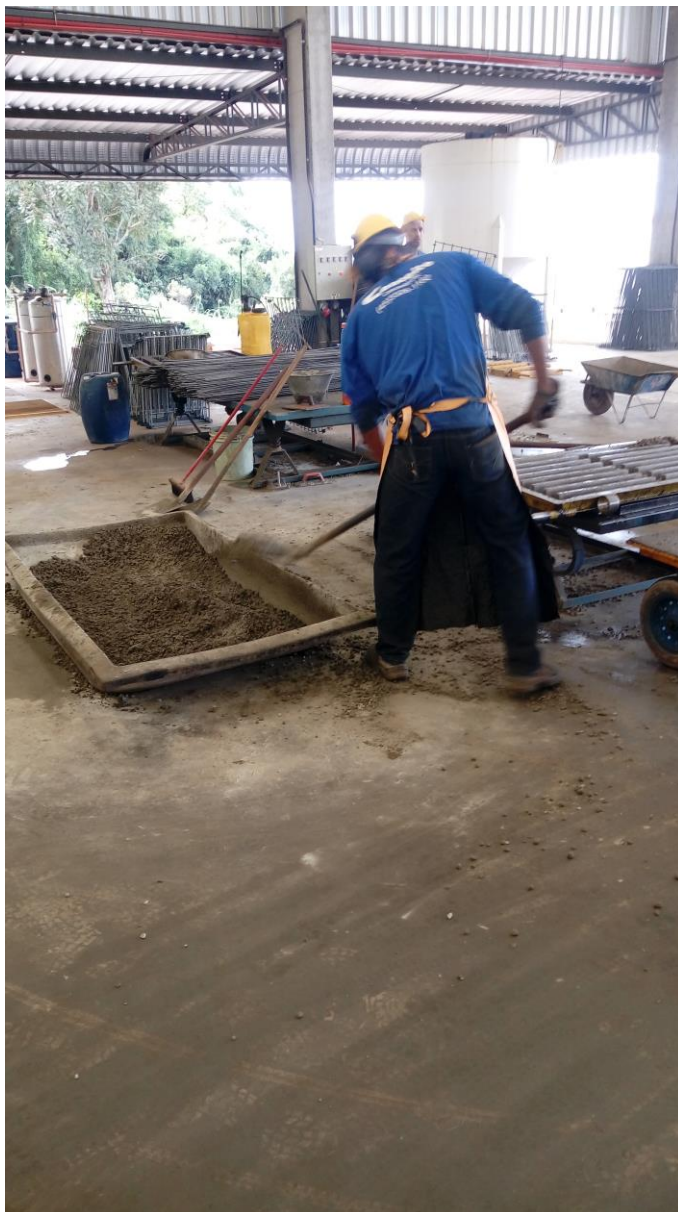
Figura 4 – Preenchimento da forma com material.
