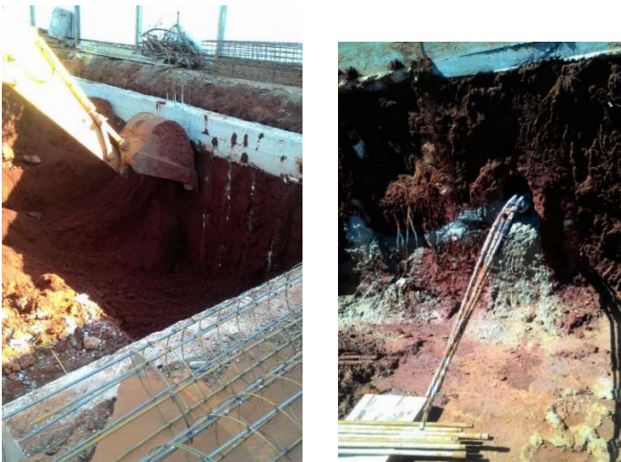
Figura 18 - Escavação e perfuração dos tirantes:
