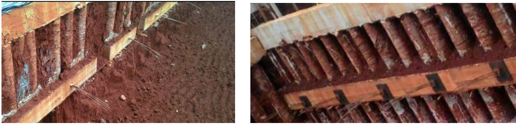
Figura 19 - Viga de travamento e protensão dos tirantes:
