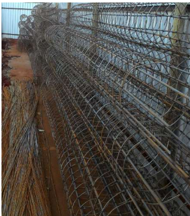
Figura 16 - Estacas e viga de coroamento:
