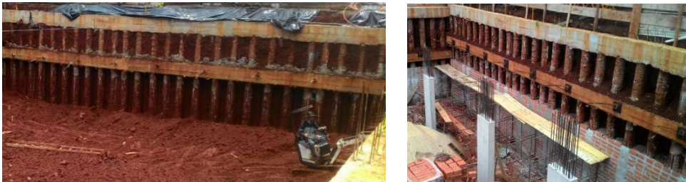
Figura 20- Escavação, fundação e estrutura:
