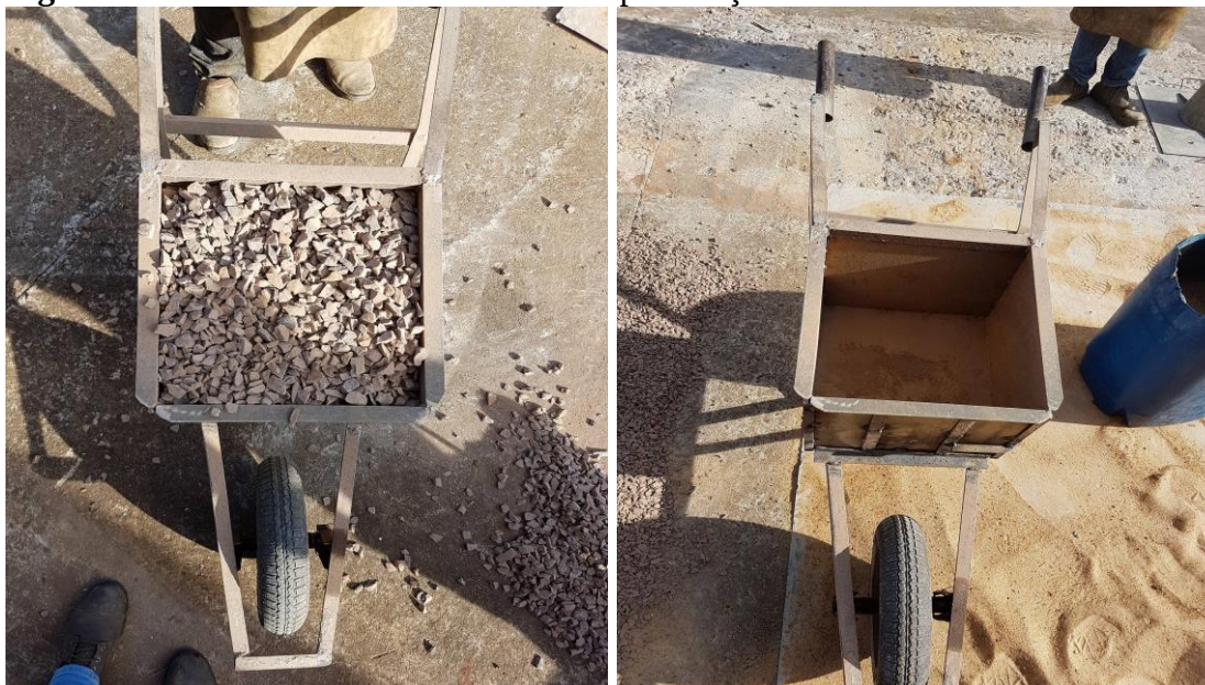
Figura 8: Carrinho utilizado como medida para traço do concreto
