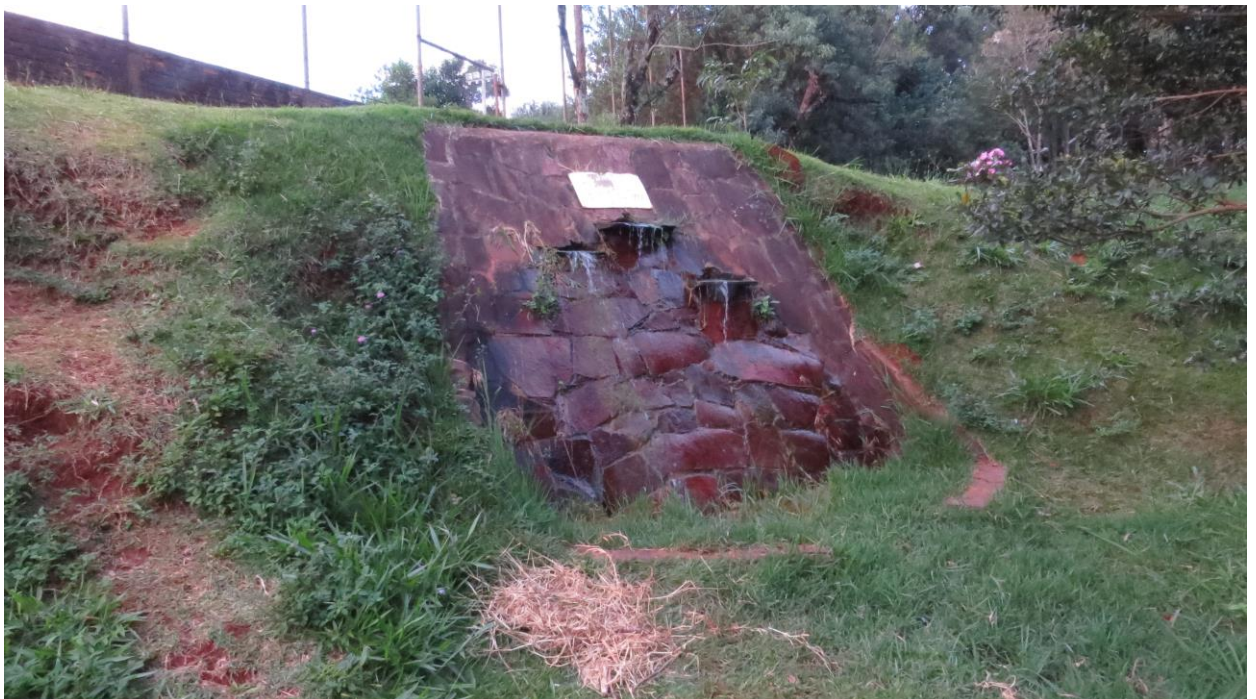
Fig. 3 – Ponto 2. Imagem da localização da fonte de água do Parque Tarquíneo Joslin dos Santos de Cascavel, Paraná. 2017. Fonte: Próprio autor.
