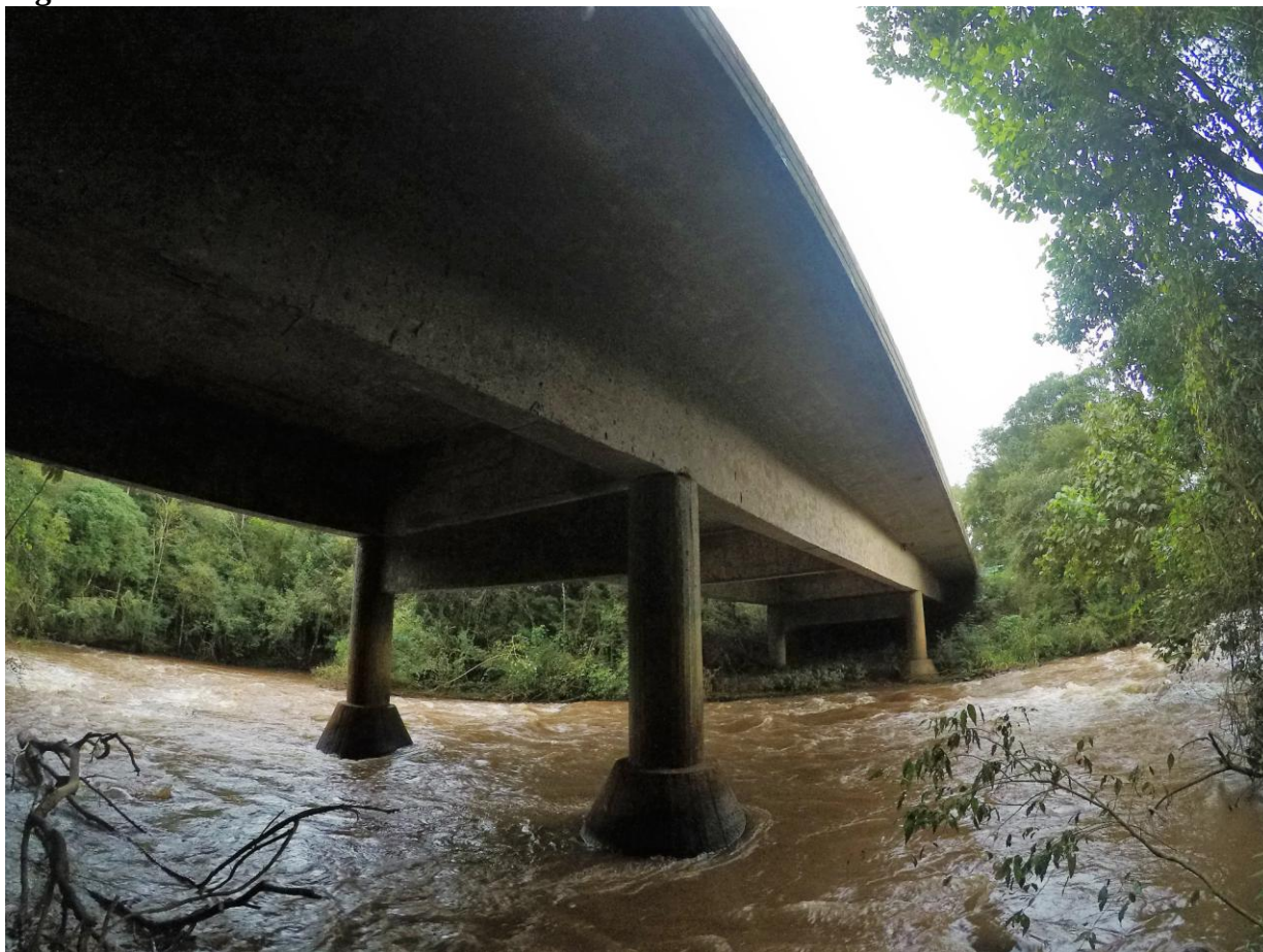
Figura 31: Ponte de concreto armado moldada in loco
