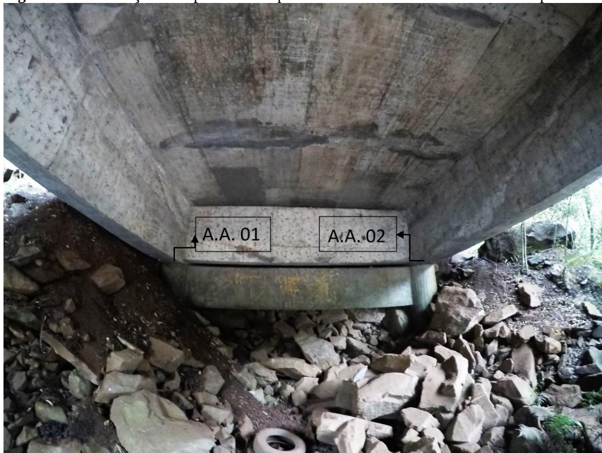
Figura 40: Localização dos aparelhos de apoio 01 e 02 na extremidade noroeste da ponte
