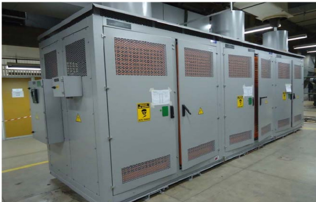
Figura 25: Sistema de excitação (Fonte: O AUTOR, 2016).
