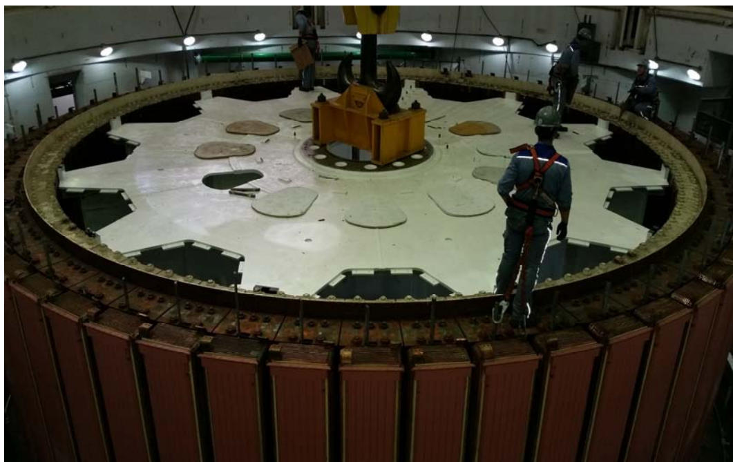
Figura 27: Rotor e aranha (Fonte: O AUTOR, 2016).
