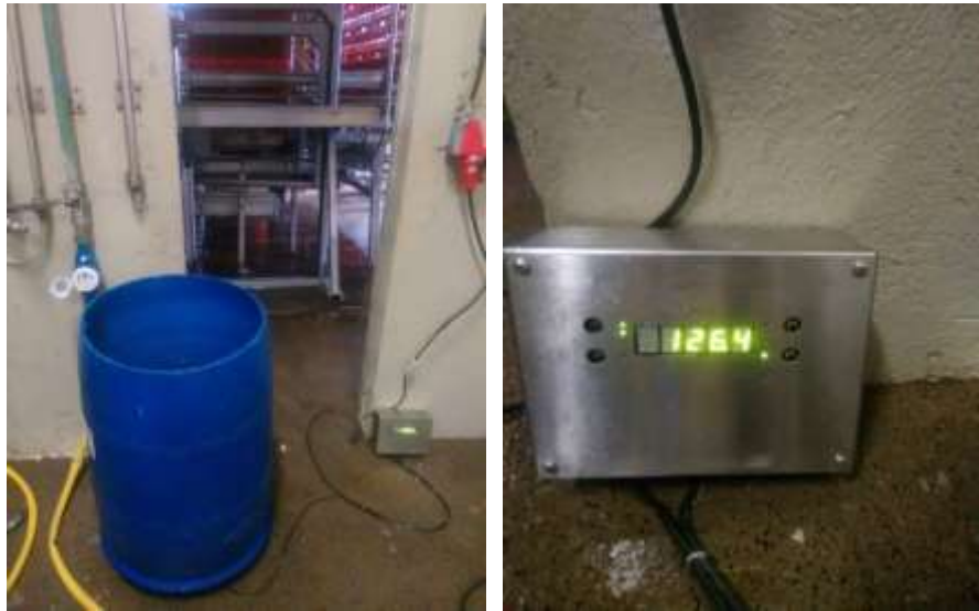
Imagem 3: Teste de medição de vazão com a balança e hidrômetro
