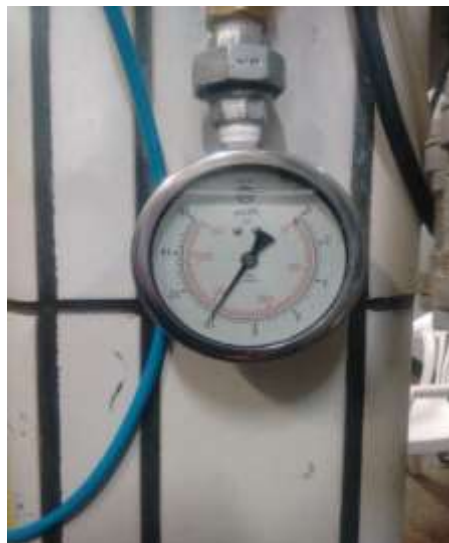
Imagem 4: Medição da pressão da água de higienização
