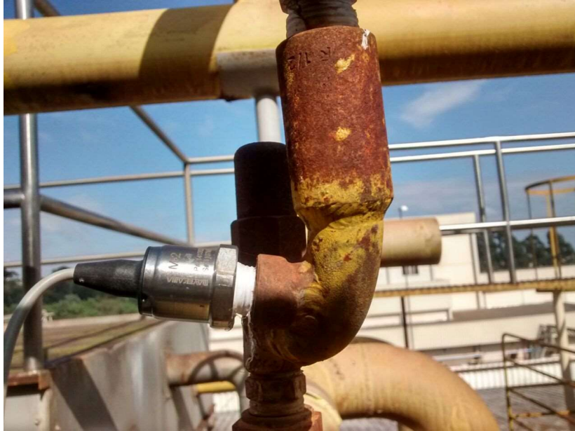
Figura 8: Transdutor de pressão na saída do condensador evaporativo
