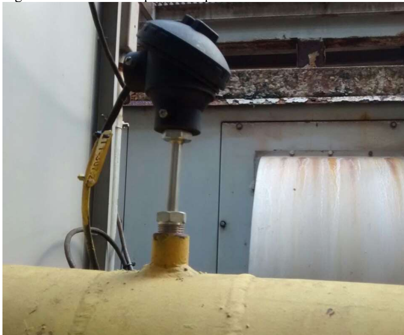
Figura 9: Sensor de temperatura tipo Pt100
