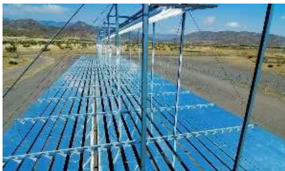
Figura 7: Concentrador plano de foco linear.
