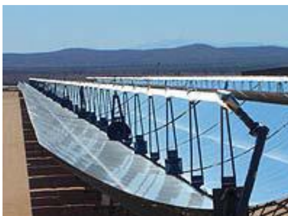
Figura 6: Concentrador parabólico de foco linear.
