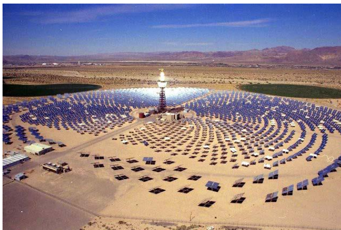
Figura 5: Concentrador de receptor central de campo heliostático.
