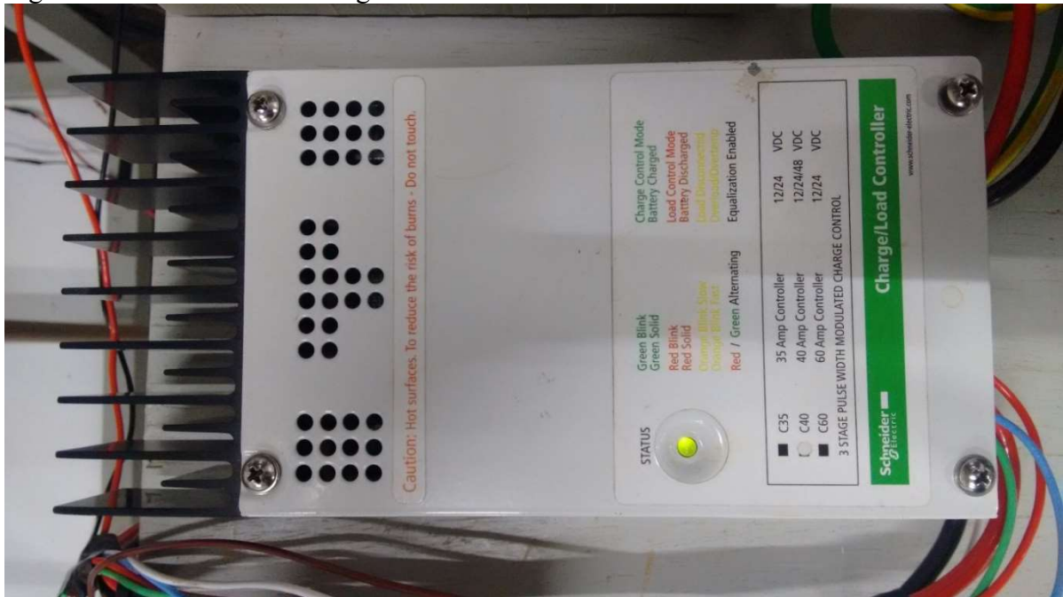
Figura 12 – Controlador de carga
