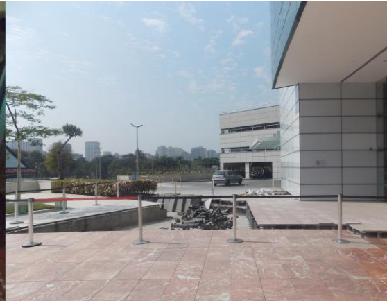
Substituição do piso na área externa
