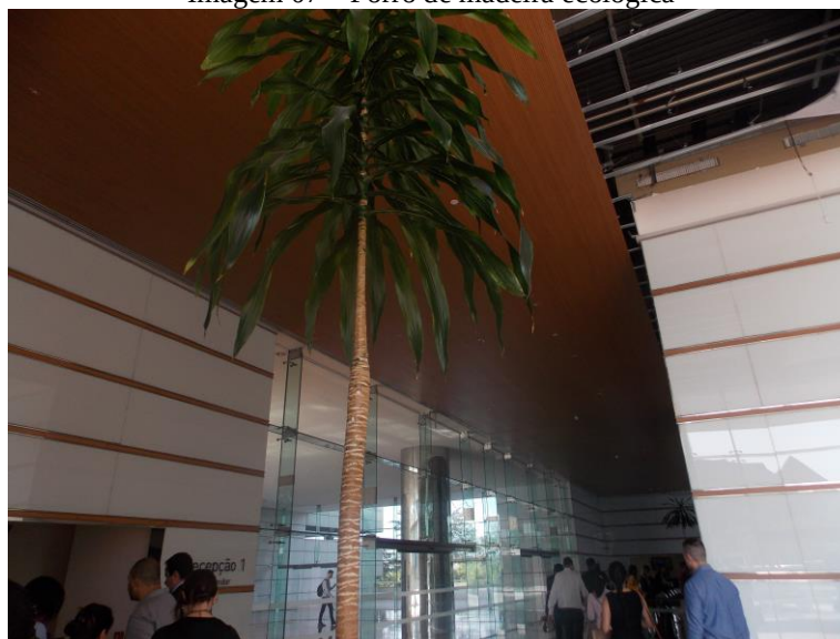
Imagem 07 – Forro de madeira ecológica
