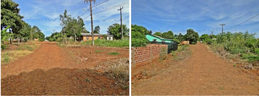
Figura 16 e 17 - ruas com pedras soltas:
