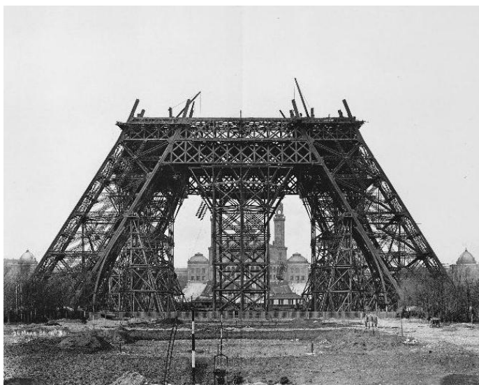
Figura 20 - Estruturação da base da Torre.
