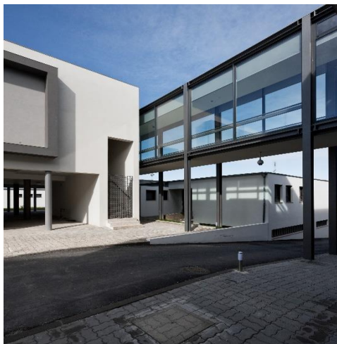
Figura 18: Detalhe estrutura metálica fachada
