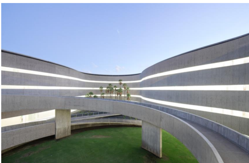
Figura 2: Vista das circulações da edificação
