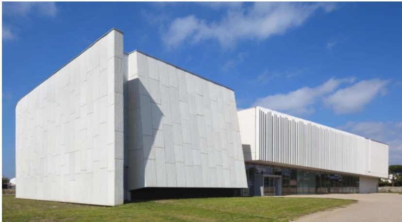
Figura 7: Vista externa da edificação
