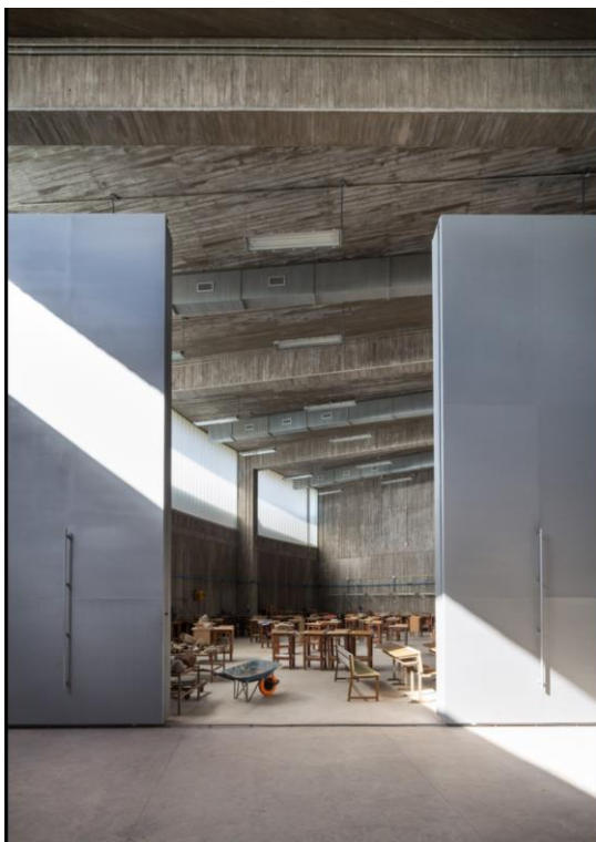
Figura 4: Vista interna da edificação – exemplificando as divisórias móveis
