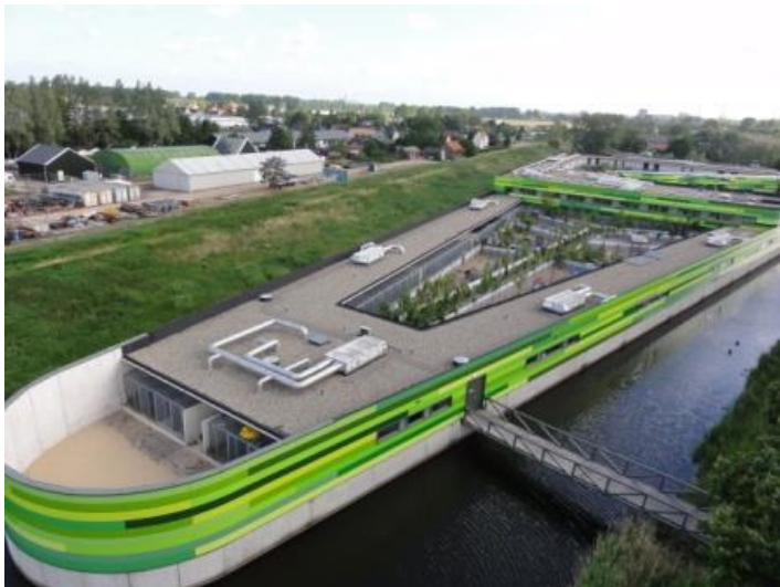
Figura 14: Fachada do Edifício Animal Shelter Amsterdam
