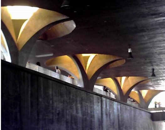
Imagem 07 – pilares rodoviária de Jaú
