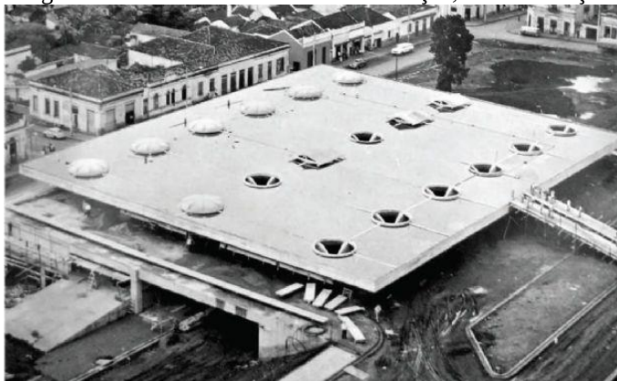
Imagem 06 – rodoviária de Jaú em construção, com instalação das clarabóias
