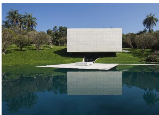
Fotografia 1 - A galeria pousando sobre o terreno
