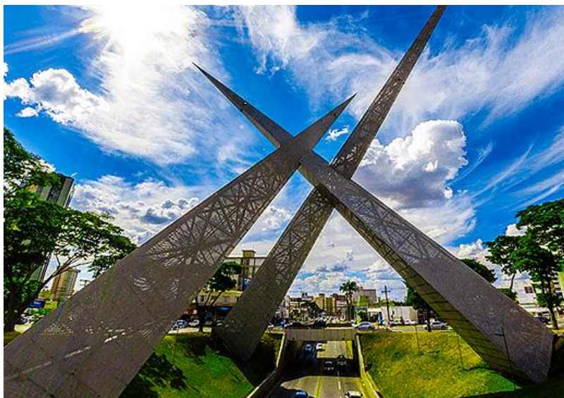
Figura 7 – Monumento Viaduto Latif Sebbá durante o dia.
