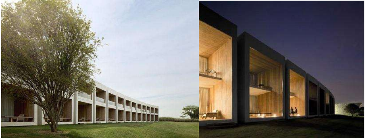
Figura 03: Apartamentos Fasano Hotel Boa Vista
