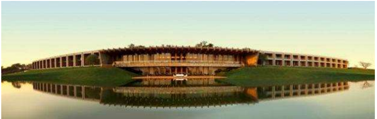
Figura 01: Fachada Panorâmica Fasano Hotel Boa Vista
