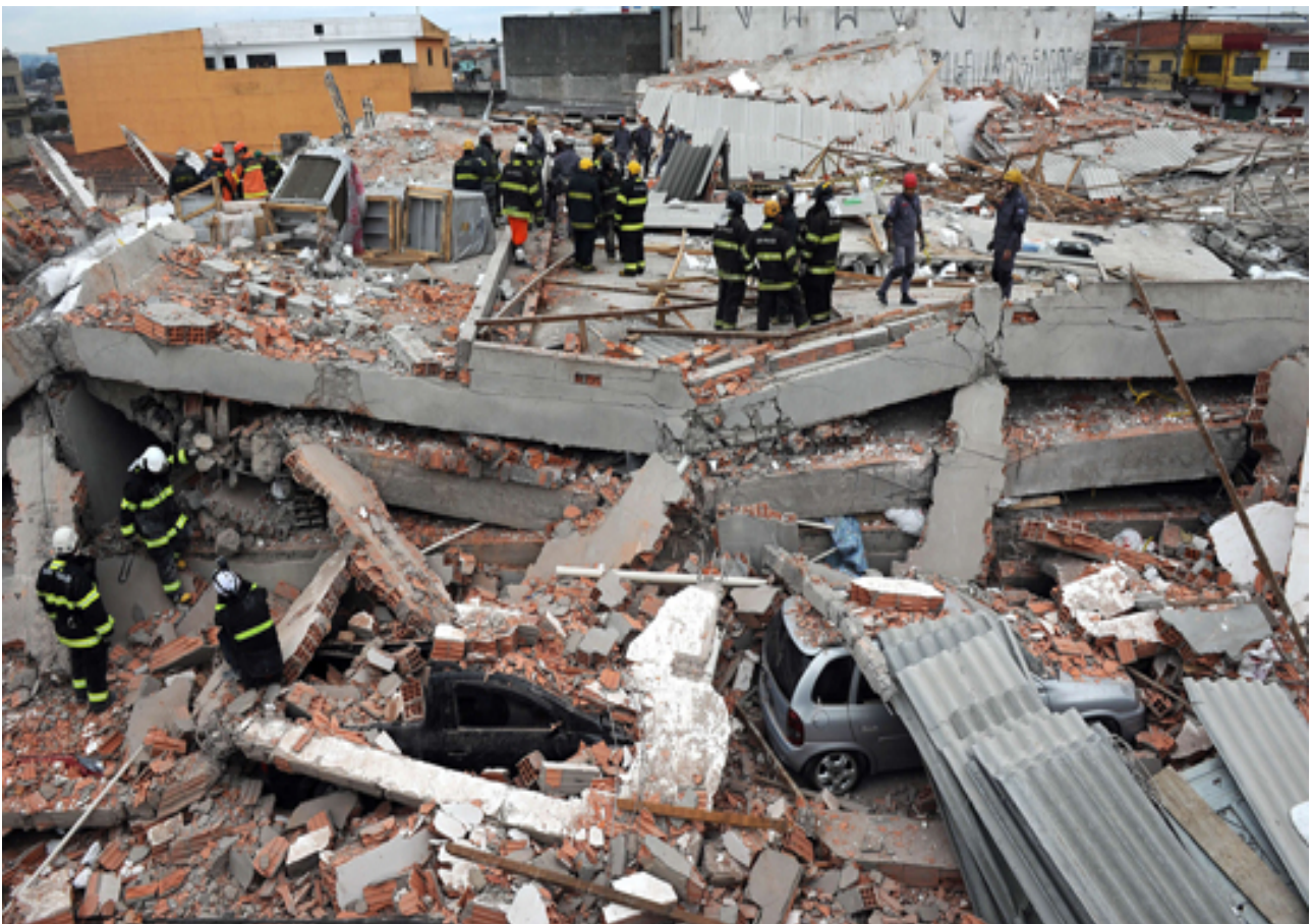
Figura 03: imagem do desabamento de uma obra irregular em SP-SP.
