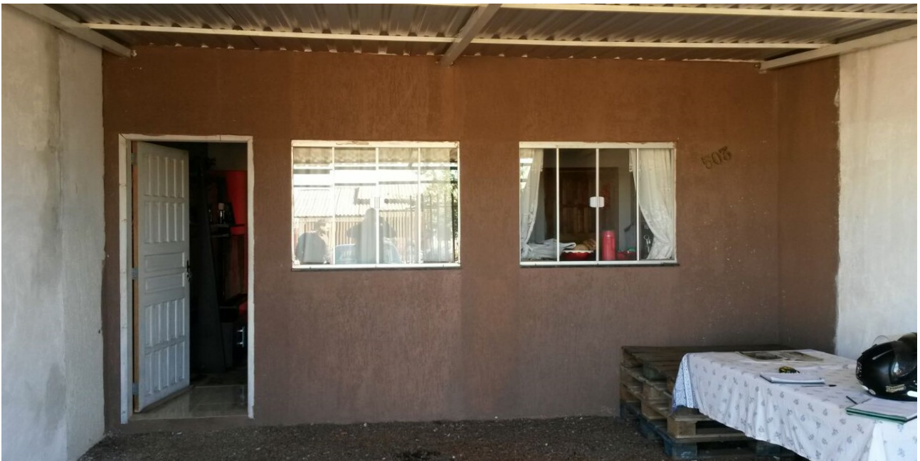
Figura 02: Área interna do ambiente.
