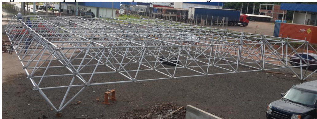
Figura 11: Treliça quadrado sobre quadrado com defasagem de meio módulo
