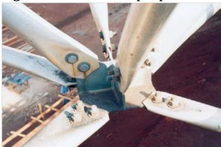
Figura 15: Nó com chapas planas
