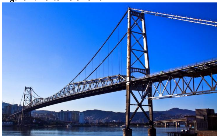
Figura 2: Ponte Hercílio Luz
