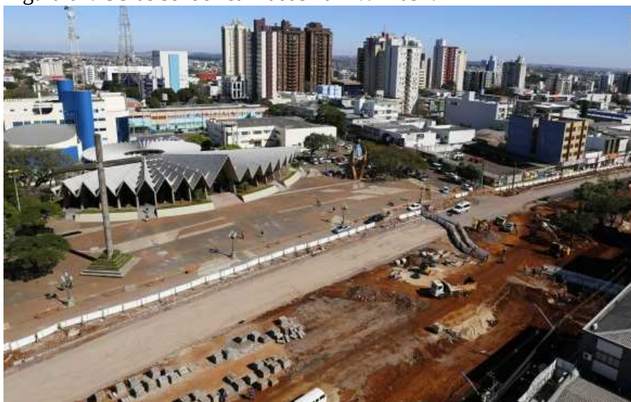
Figura 01: Obras sendo realizadas na Av. Brasil.
