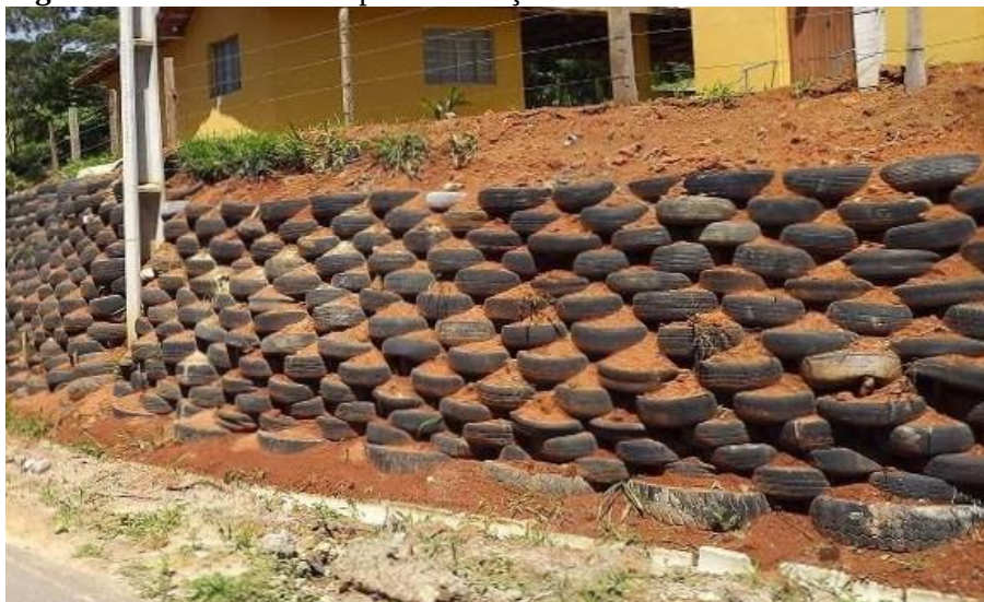
Figura 3: Pneus utilizados para contenção.
